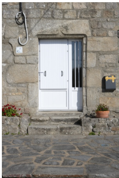
Détail de la porte du 1er logement (2 place des Perrières). Phot. Denis Pillet IVR52_20074401333NUCA
