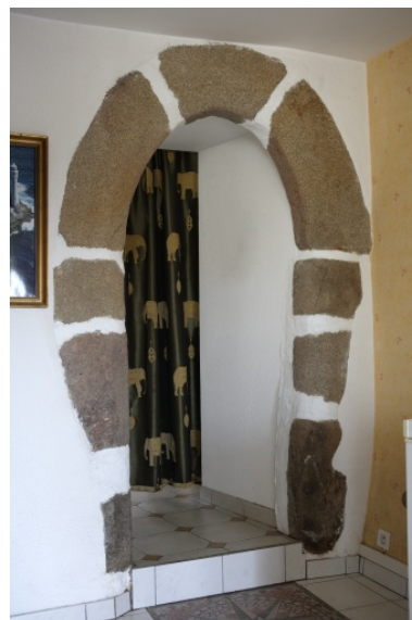
Détail de la porte arrière (sur potager) du 3e logement (4 place des Perrières). Phot. Denis Pillet IVR52_20074401334NUCA
