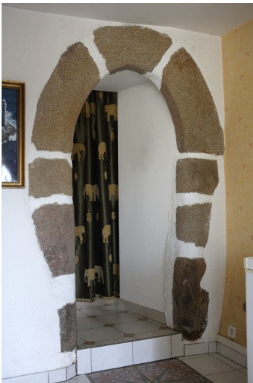
Détail de la porte arrière (sur potager) du 3e logement (4 place des Perrières).
