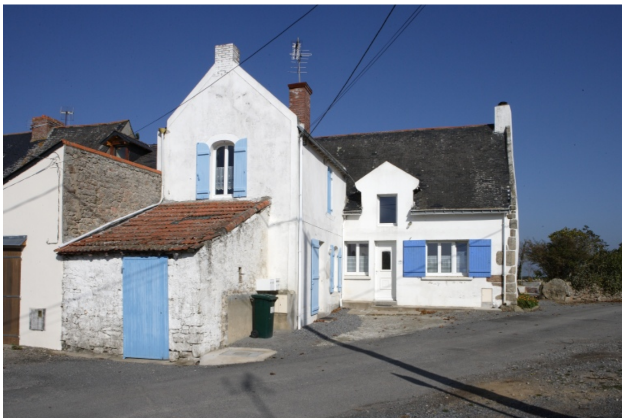
Vue du 5e logement (6 place des Perrières).
