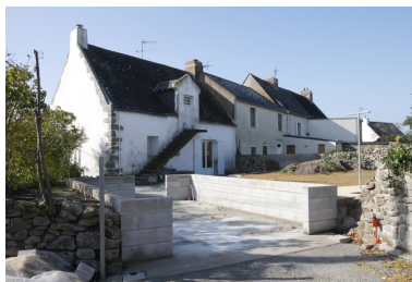
Vue de la façade nord de la rangée. Phot. Denis Pillet IVR52_20074401338NUCA
