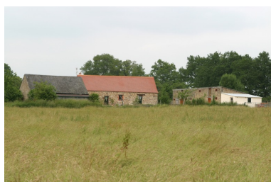
Vue d'ensemble depuis la route de Thorigné au sud : la remise, le logis, l'étable-porcherie. Phot. François Lasa IVR52_20035302132NUCA
