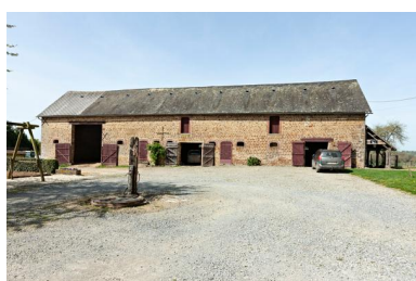
Corps de bâtiment oriental : remise, grange, étables, loge en appentis pour pressoir édifée en bois Phot. Yves Guillotin IVR52_20195300475NUCA
