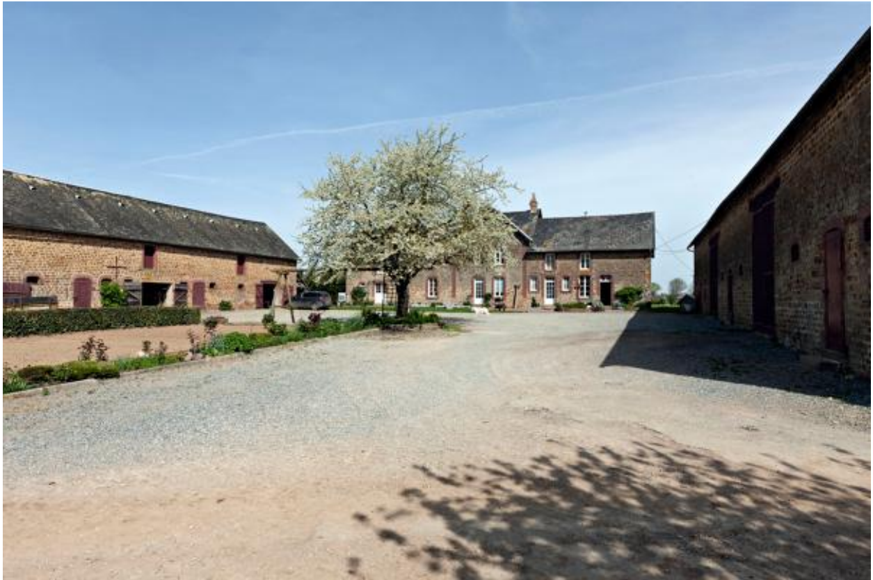
Ferme des Longchamps, vue d'ensemble depuis le sud
