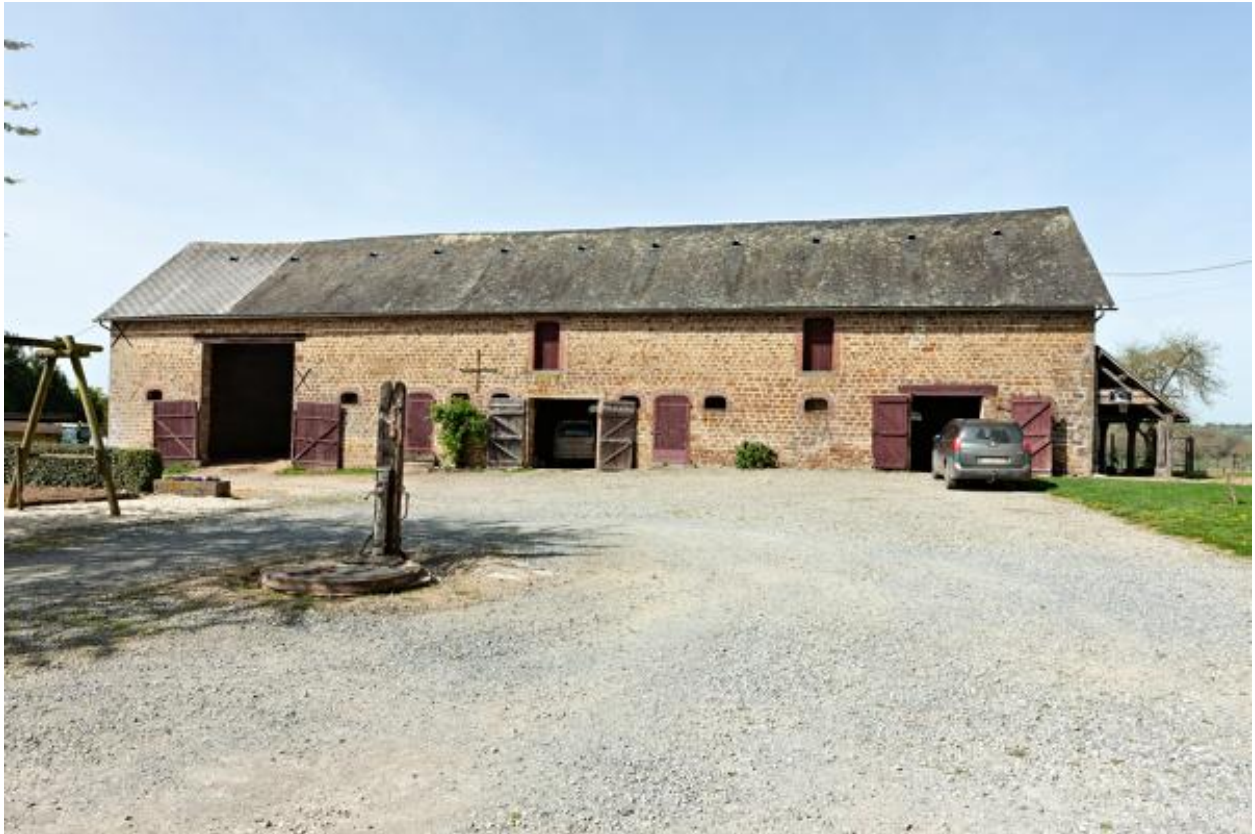
Corps de bâtiment oriental : remise, grange, étables, loge en appentis pour pressoir édiflée en bois
