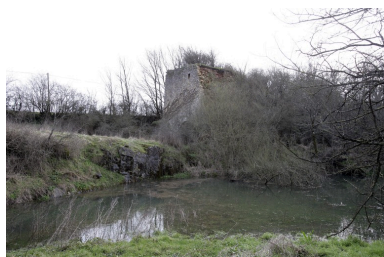
Vue d'ensemble du site depuis le nord-ouest : au premier plan, l'ancienne carrière, au second, le four à chaux.
