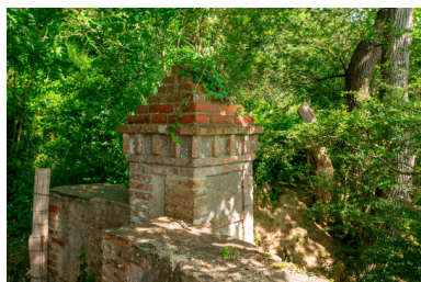
Le belvédère sur la Mayenne, détail d'un pilier. Phot. Pierre-Bernard Fourny IVR52_20235300451NUCA
