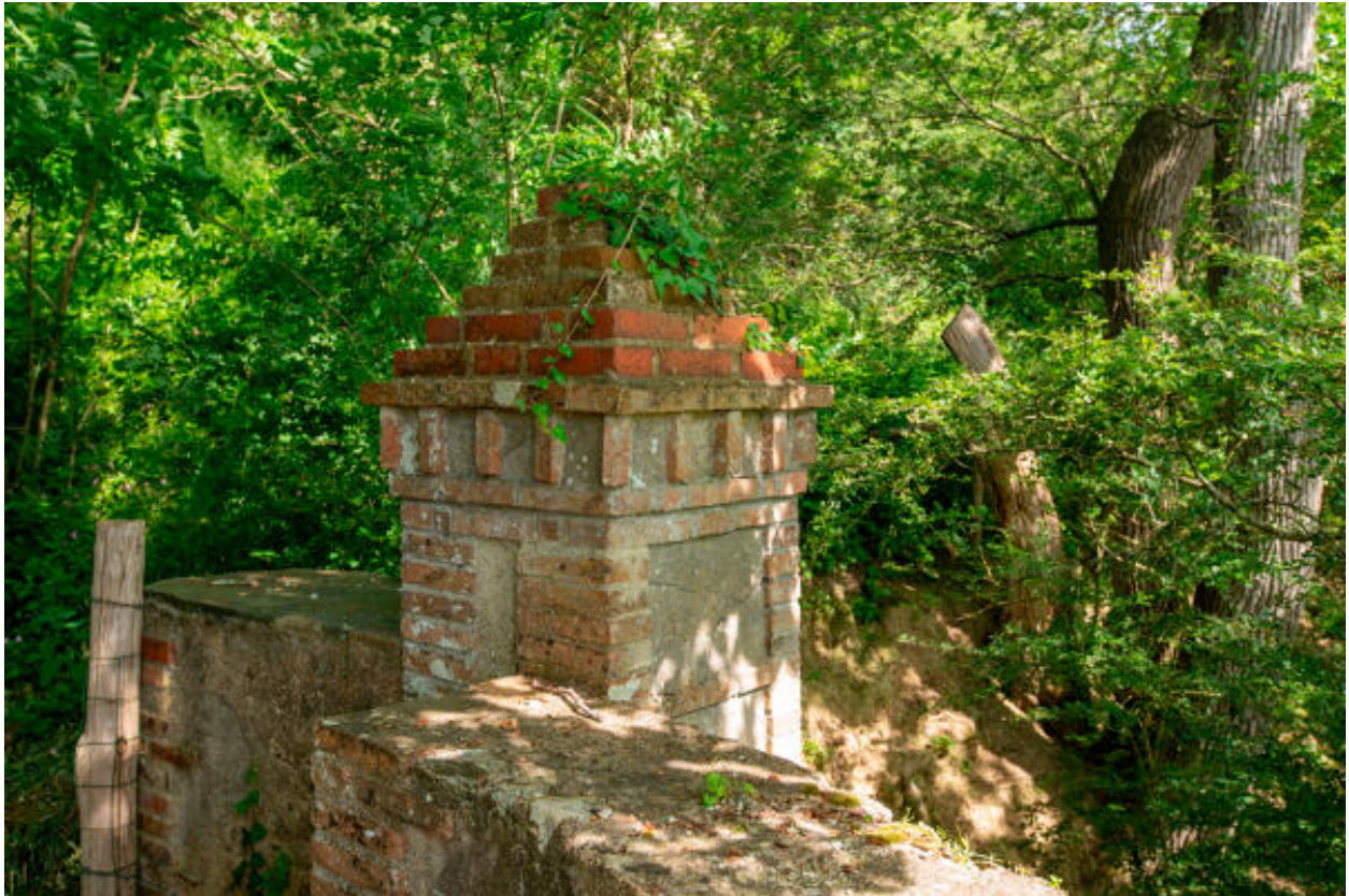
Le belvédère sur la Mayenne, détail d'un pilier.
