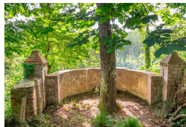
Le belvédère sur la Mayenne. Phot. Pierre-Bernard Fourny IVR52_20235300450NUCA
