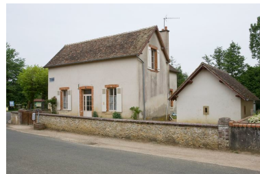
La mairie-école, élévation sur rue. Phot. Yves Guillotin IVR52_20107202293NUCA
