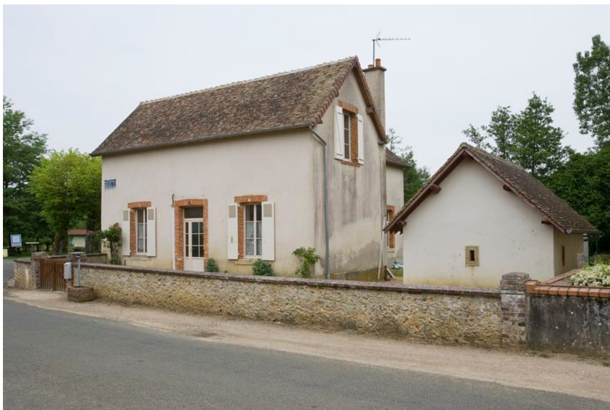
La mairie-école, élévation sur rue.
