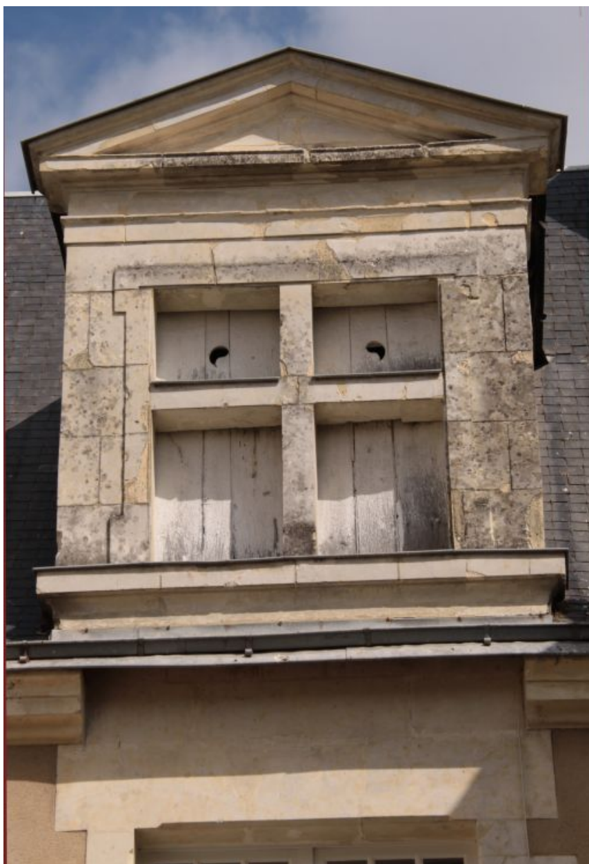
Façde sur la petite cour : lucarne à fronton.
