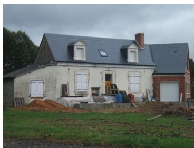
Façade antérieure sur rue : hôtel en L, à cour antérieure. Phot. Stéphanie Aquilon IVR52_20097202112NUCA
