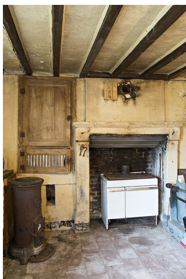
Pièce à feu, détail : placard mural au-dessus du potager, cheminée. Phot. Pierre-Bernard Fourny IVR52_20147200267NUCA
