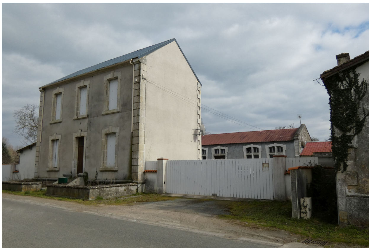
L'ancienne école vue depuis l'ouest.
