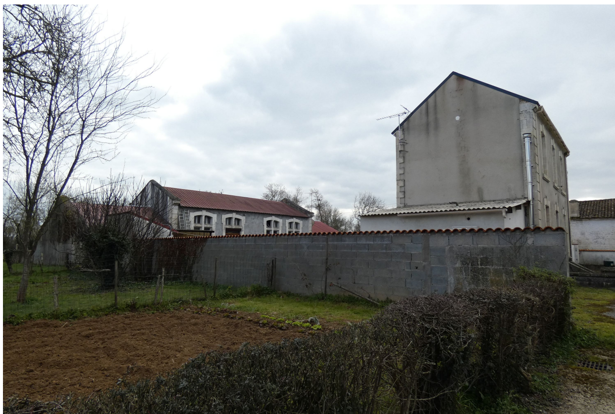
L'ancienne école vue depuis le nord.
