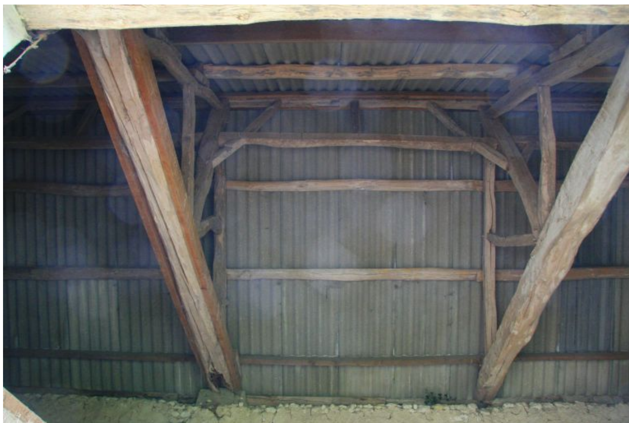
La grange : la charpente à pannes avec sous-faîtage.
