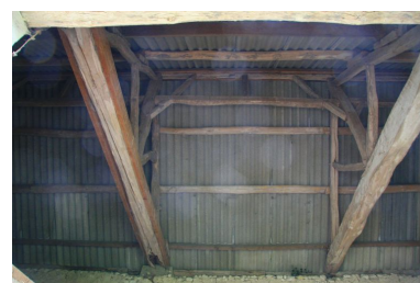
La grange : la charpente à pannes avec sous-faîtage. Phot. Jean-Baptiste Darrasse IVR52_20077202535NUCA
