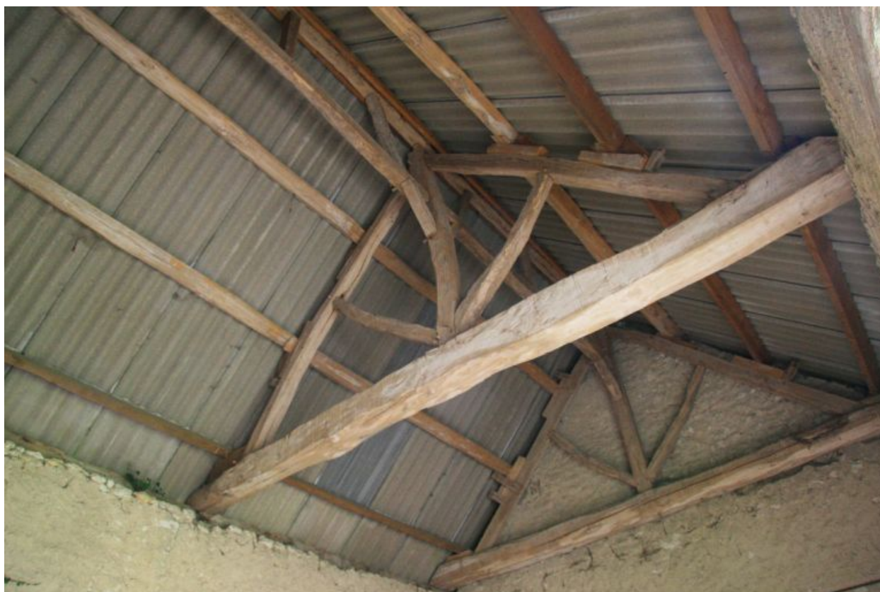
La grange : charpente à pannes.
