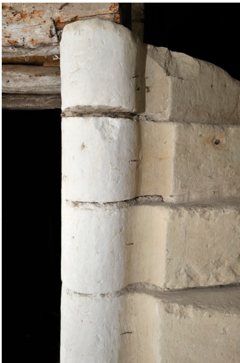
Détail des marches de l'escalier : noyau et collet à gorge
