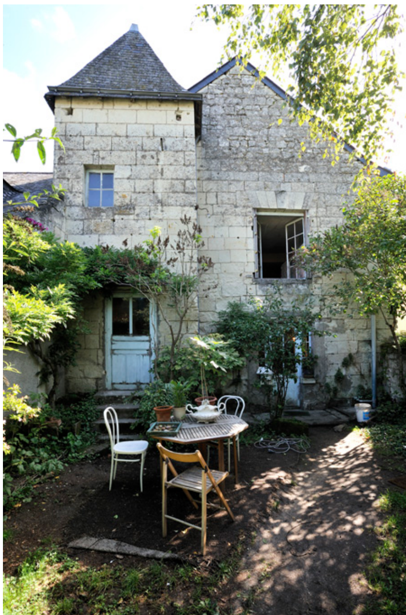
Vue générale de la façade principale (ouest)
