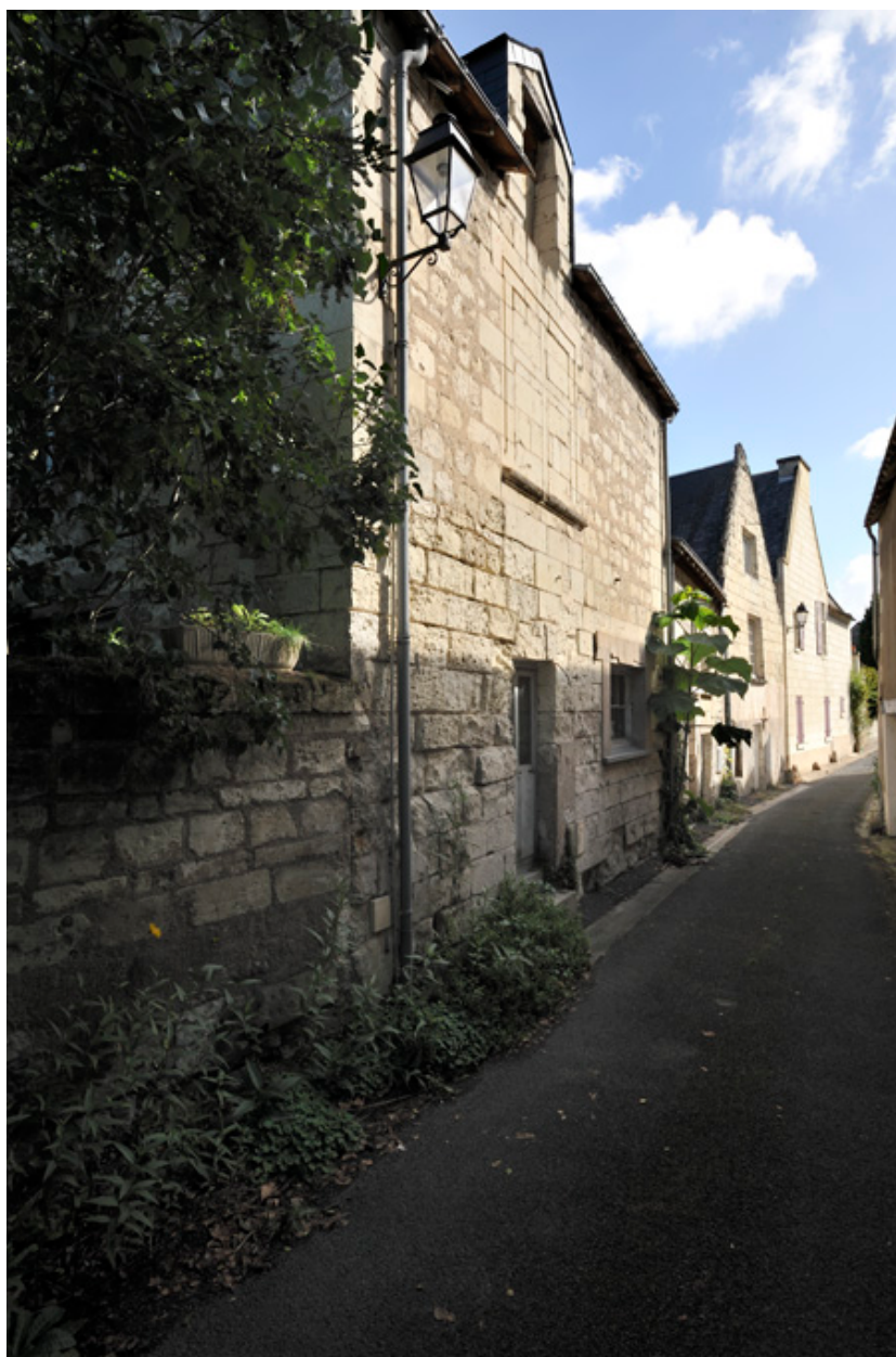
Façade sur rue à croisée obturée
