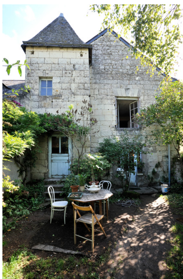
Vue générale de la façade principale (ouest) Phot. Bruno Rousseau, Phot. Youenn Communeau IVR52_20114902499NUCA
