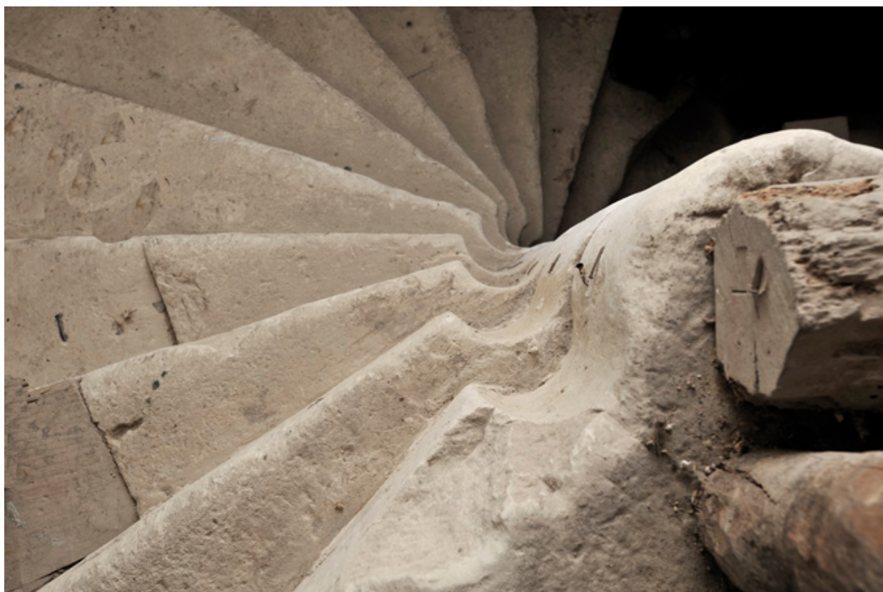
Détail de l'escalier : jeu des gorges et marches de la vis
