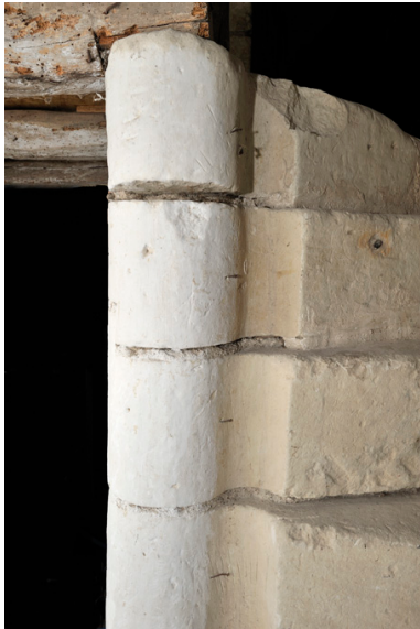
Détail des marches de l'escalier : noyau et collet à gorge Phot. Bruno Rousseau, Phot. Youenn Communeau IVR52_20114902501NUCA
