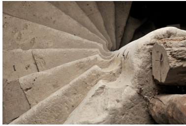
Détail de l'escalier : jeu des gorges et marches de la vis Phot. Bruno Rousseau, Phot. Youenn Communeau IVR52_20114902502NUCA
