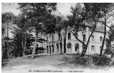
Angle sud-est de la villa Saint-Clair sur sa dune.
