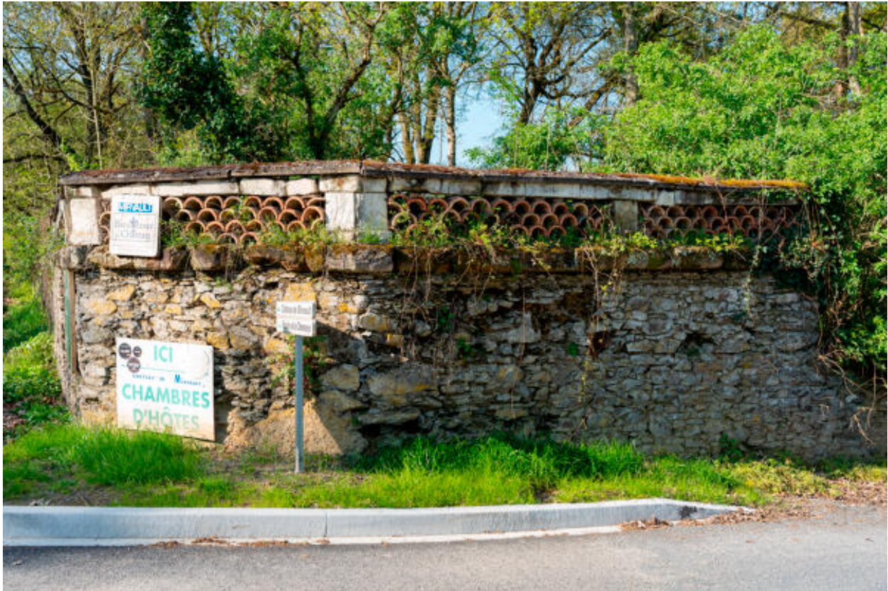
Le soubassement du pavillon.
