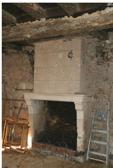
La maison du meunier, extension du XIXe s. : cheminée. IVR52_20067207523NUCA
