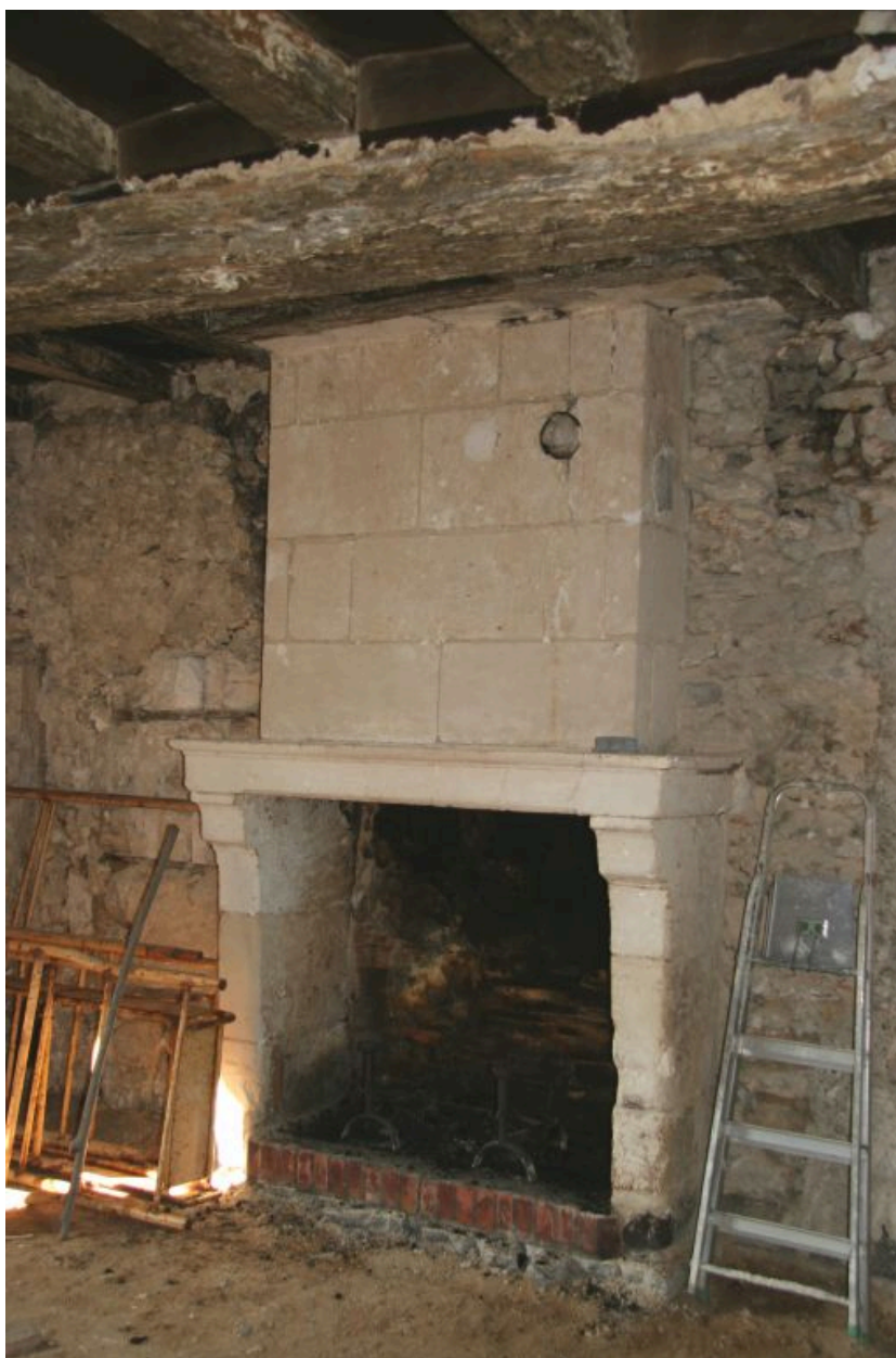
La maison du meunier, extension du XIXe s. : cheminée.
