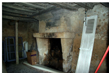
L'ancienne maison du meunier : cheminée. IVR52_20067207522NUCA
