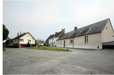
Vue d'ensemble depuis le nord- ouest de l'ancien lieu-dit de la Pinocherie. La maison est au fond. Phot. François Lasa IVR52_20075302205NUCA
