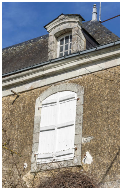
Une fenêtre et une lucarne. Phot. Pierre-Bernard Fourny IVR52_20225300276NUCA
