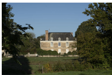
La maison. Phot. Pierre-Bernard Fourny IVR52_20235301659NUCA
