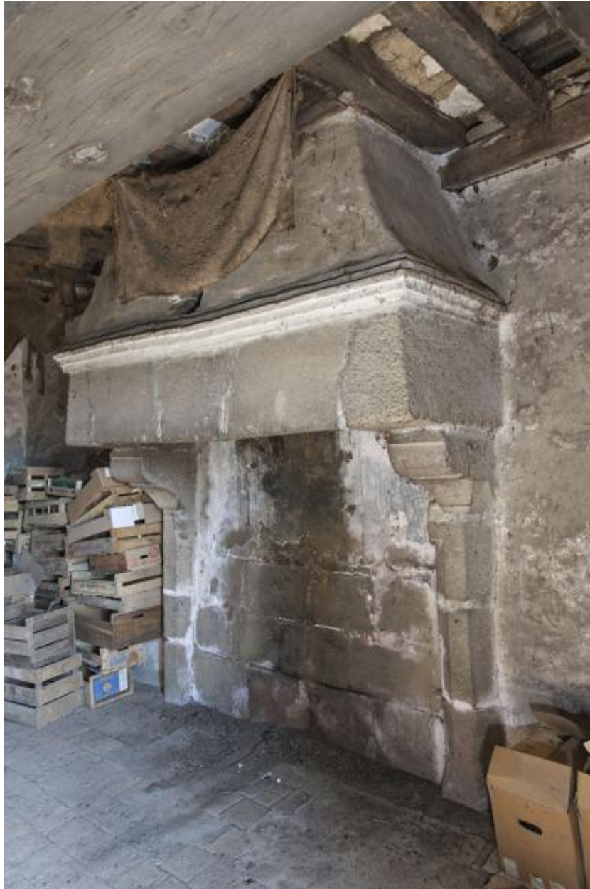
Cheminée du premier niveau, demeure de Bignon.
