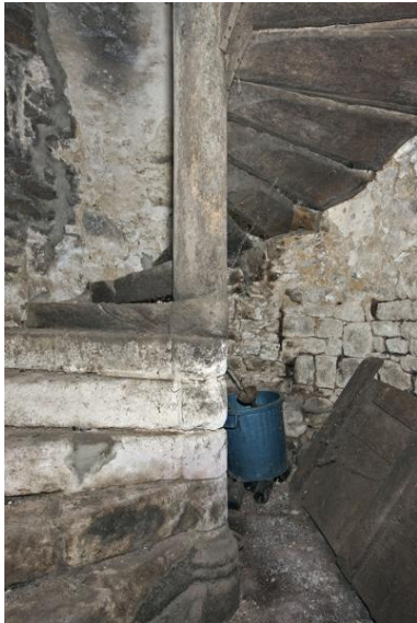
Escalier à vis, demeure de Bignon Phot. Yves Guillotin IVR52_20185300453NUCA
