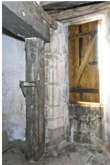
Fenêtre du premier niveau, fenêtre du mur nord. Phot. Yves Guillotin IVR52_20185300457NUCA
