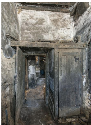
Cellier, rez-de-chaussée, vue vers la tour d'escalier. Phot. Yves Guillotin IVR52_20185300450NUCA
