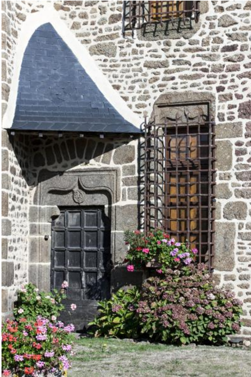
Porte et fenêtre à accolade, façade sud.
