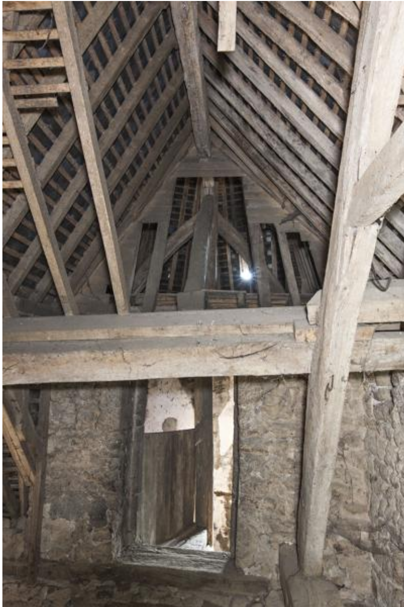
Charpente de la demeure de Bignon, côté sud.
