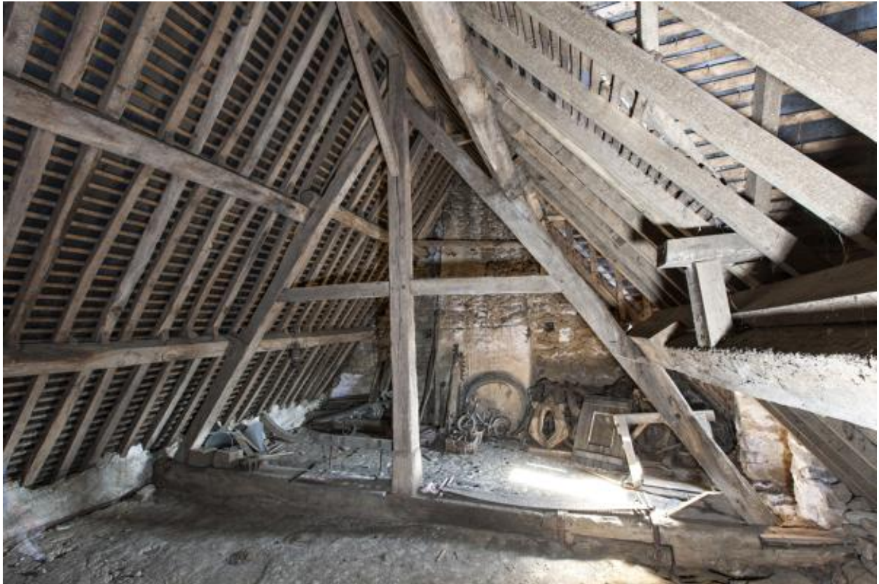
Charpente de la demeure de Bignon.
