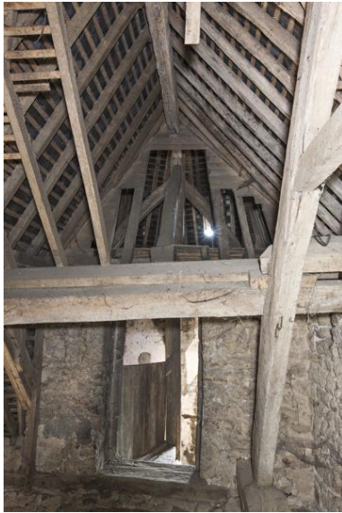
Charpente de la demeure de Bignon, côté sud. Phot. Yves Guillotin IVR52_20185300459NUCA
