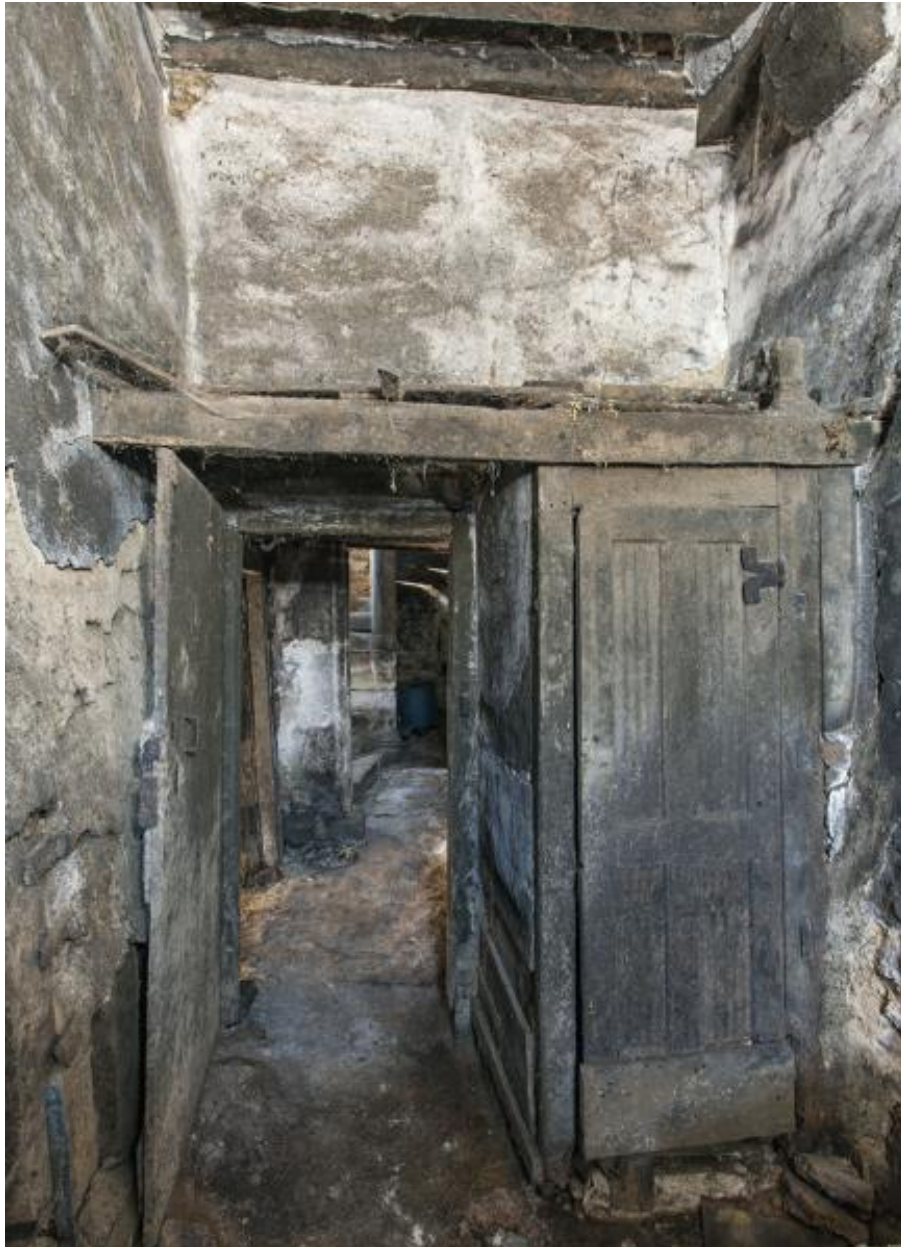
Cellier, rez-de-chaussée, vue vers la tour d'escalier.
