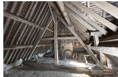
Charpente de la demeure de Bignon. Phot. Yves Guillotin IVR52_20185300458NUCA
