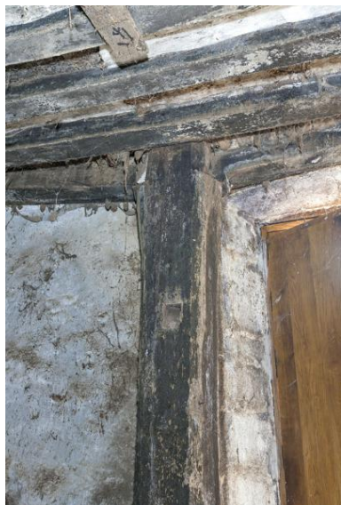
Poteau contre le mur gouttereau sud, soutenant la poutre du plancher du niveau de comble. Phot. Yves Guillotin IVR52_20185300447NUCA
