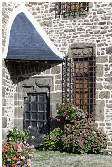
Porte et fenêtre à accolade, façade sud. Phot. Yves Guillotin IVR52_20185300432NUCA
