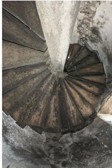
Escalier à vis, marches vues du dessous. Phot. Yves Guillotin IVR52_20185300454NUCA
