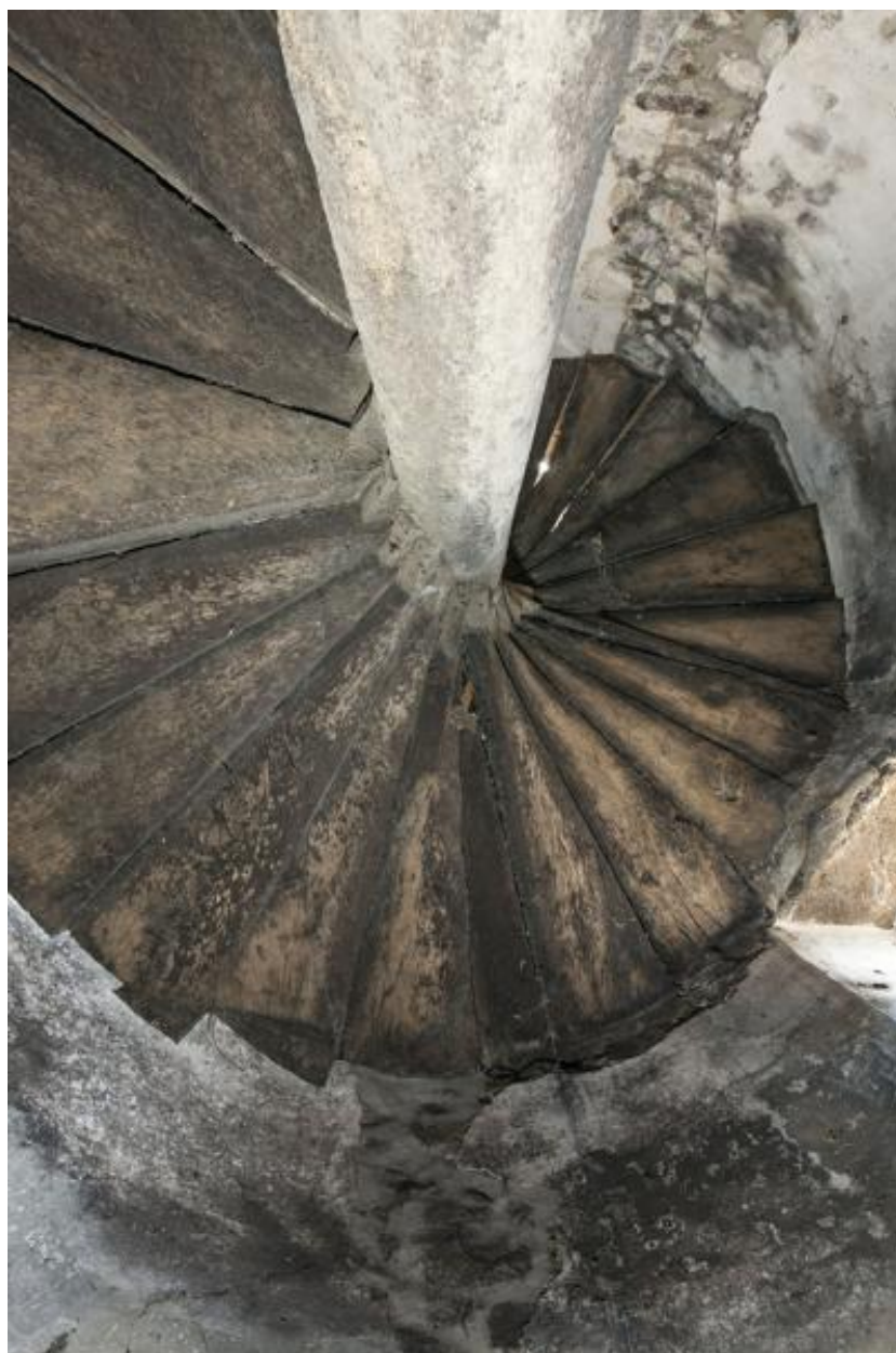
Escalier à vis, marches vues du dessous.
