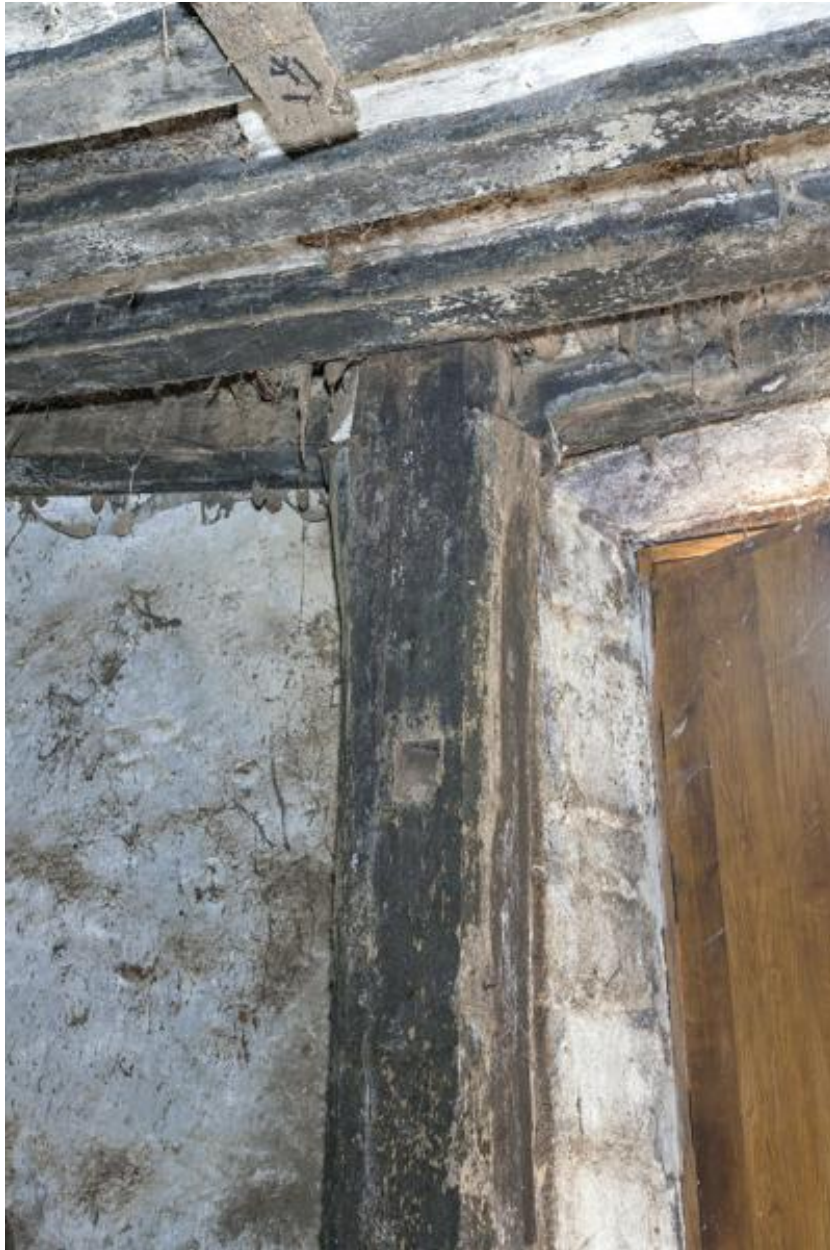
Poteau contre le mur gouttereau sud, soutenant la poutre du plancher du niveau de comble.
