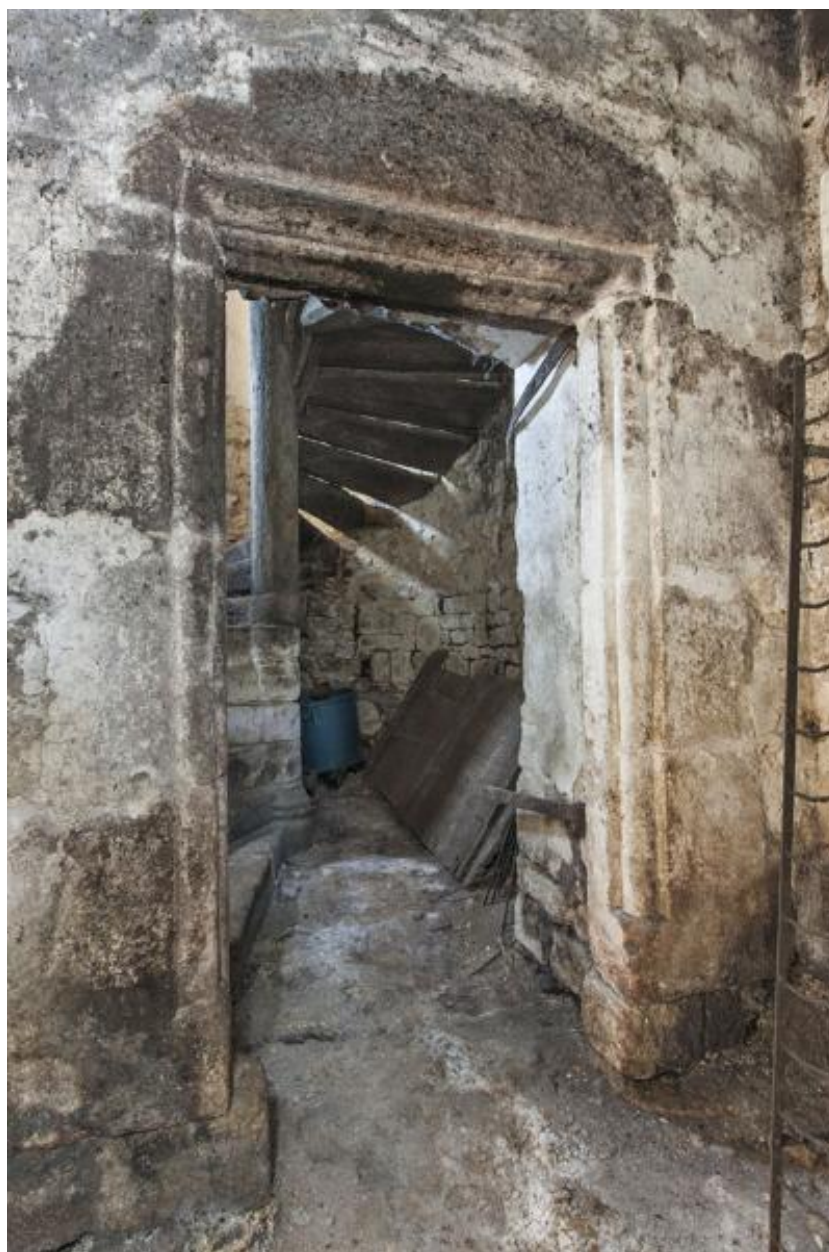
Porte d'accès entre la salle basse et la tour d'escalier.
