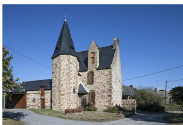
Demeure de Bignon, façade sud. Phot. Yves Guillotin IVR52_20185300430NUCA
