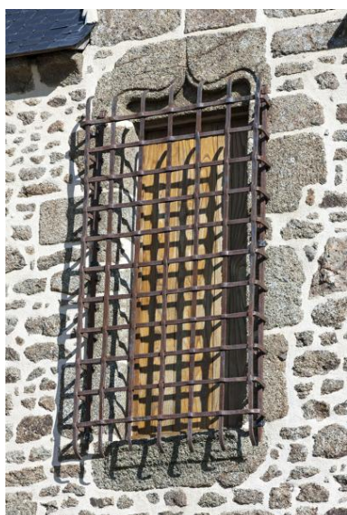
Fenêtre et grille en fer forgé du premier niveau, demeure de Bignon. Phot. Yves Guillotin IVR52_20185300433NUCA
