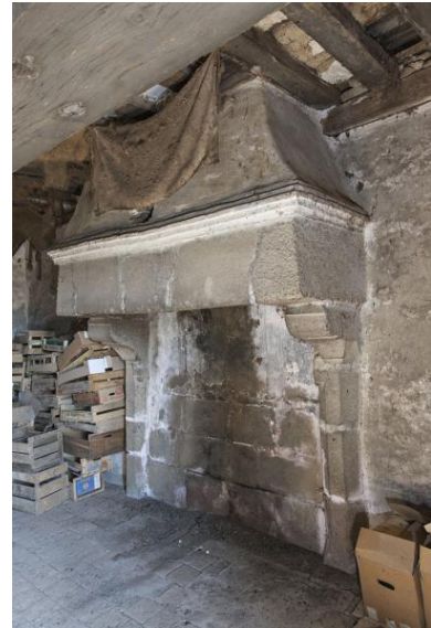
Cheminée du premier niveau, demeure de Bignon. Phot. Yves Guillotin IVR52_20185300455NUCA
