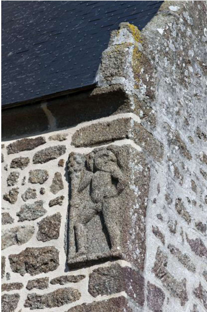
Hercule sculpté dans le chaînage d'angle sud-est de la demeure de Bignon.
