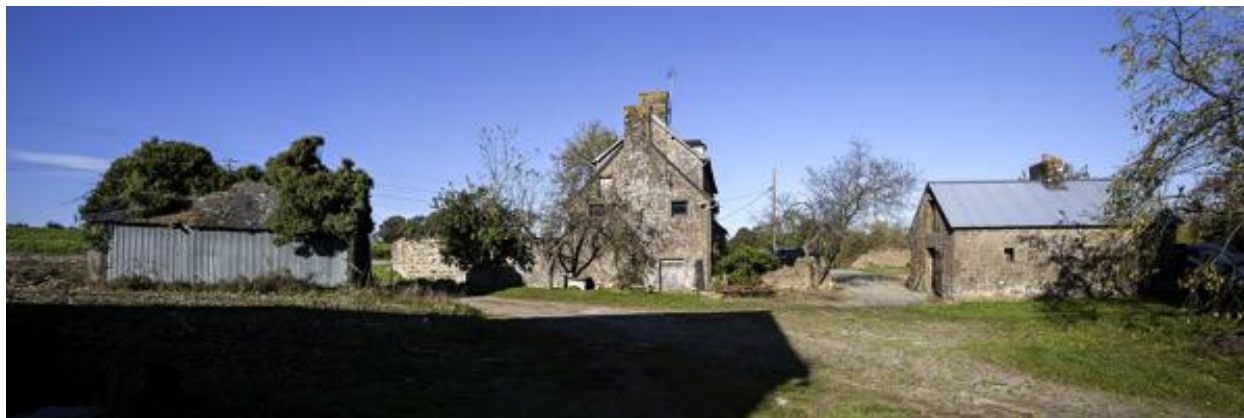
Remise, maison de maître et fournil de la Rivière.
