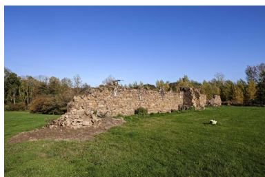
Portion nord du mur de clôture du jardin. Phot. Yves Guillotin IVR52_20215301822NUCA
