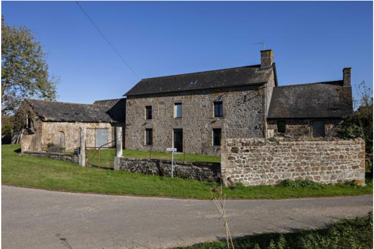
Façade occidentale de la maison de maître de la Rivière
