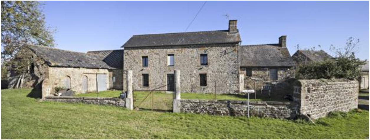
Façade occidentale de la maison de maître de la Rivière.
