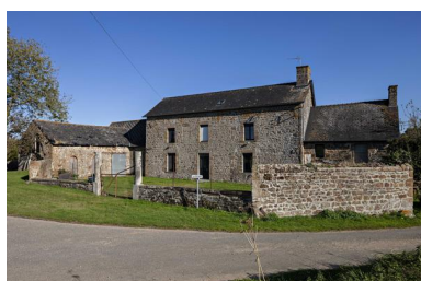
Façade occidentale de la maison de maître de la Rivière Phot. Yves Guillotin IVR52_20215301824NUCA
