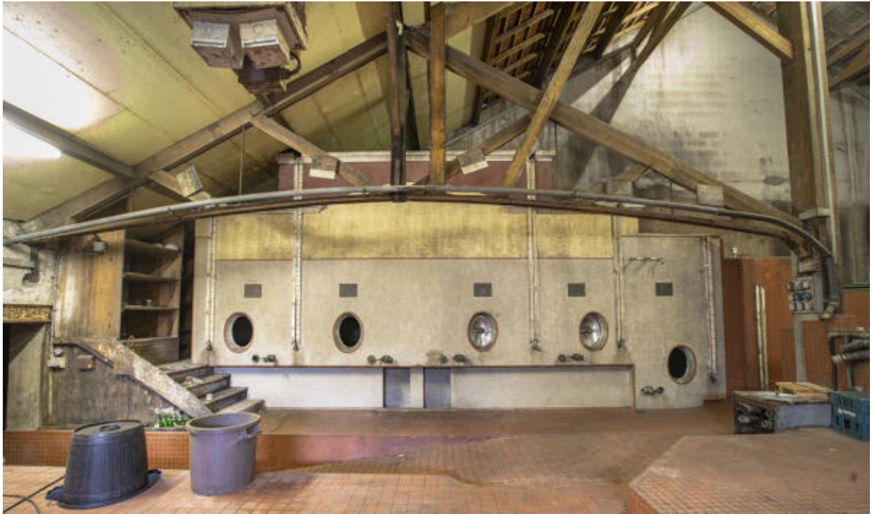
Cuverie principale, niveau supérieur.
