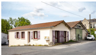
Maisons de vendangeurs, superposées à l'entrepôt de stockage des bouteilles. Phot. Pierre-Bernard Fourny IVR52_20214400328NUCA
