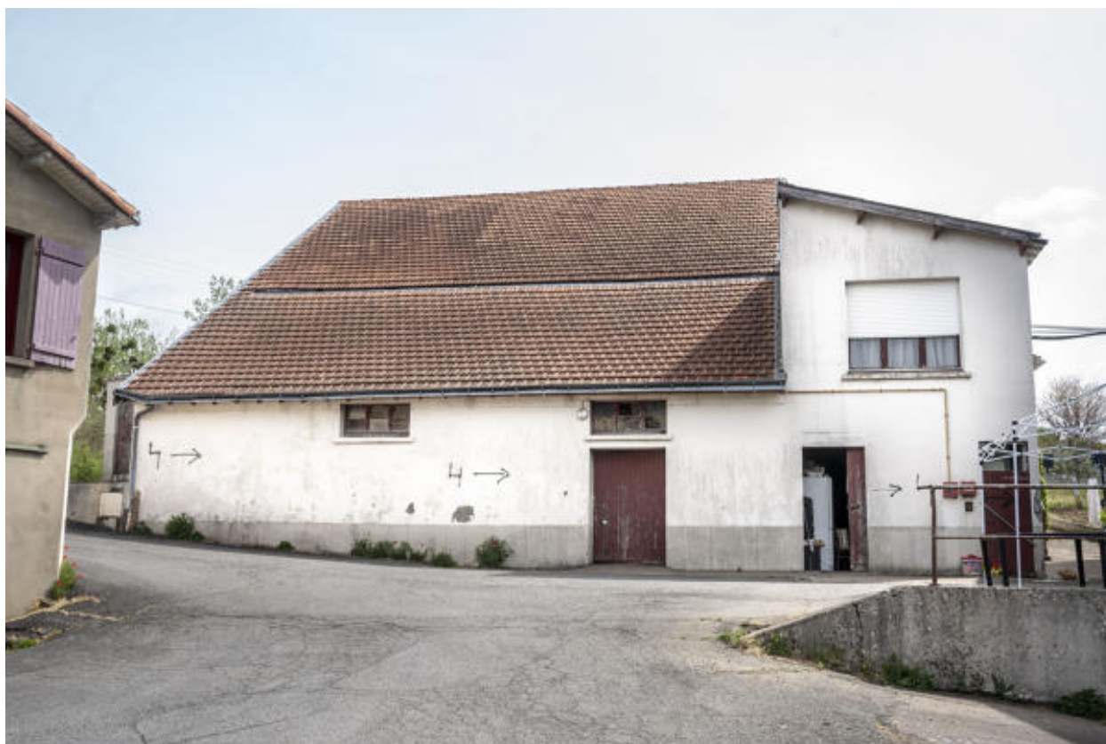
Bâtiment de filtrage et de mise en bouteille, site de la rue des Rosiers.
