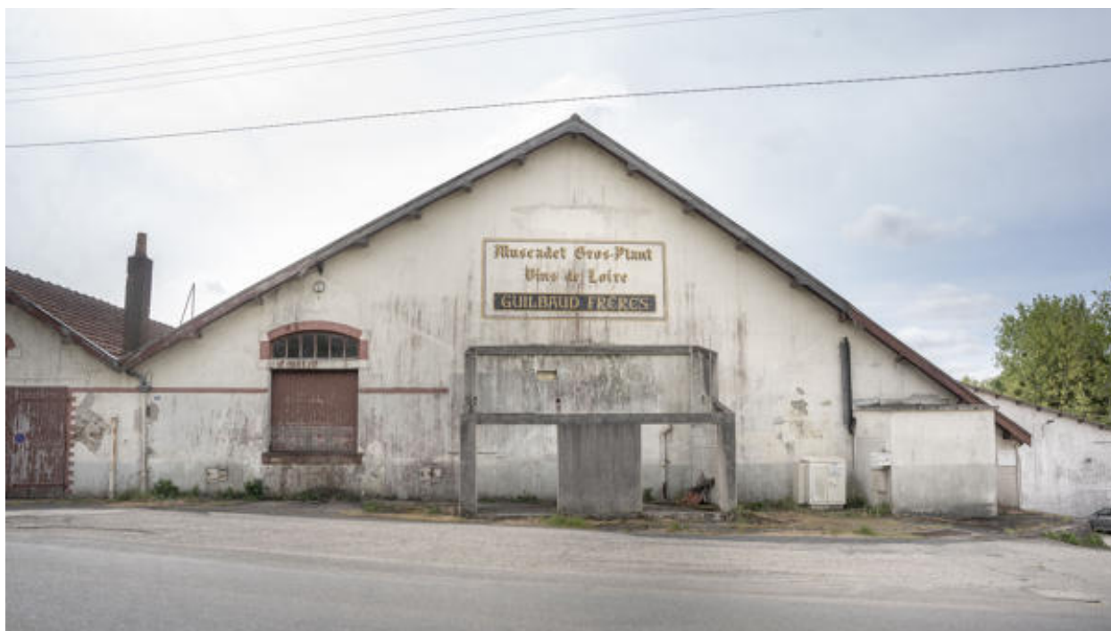
Bâtiment de la cuverie principale, site de la rue des Rosiers.
