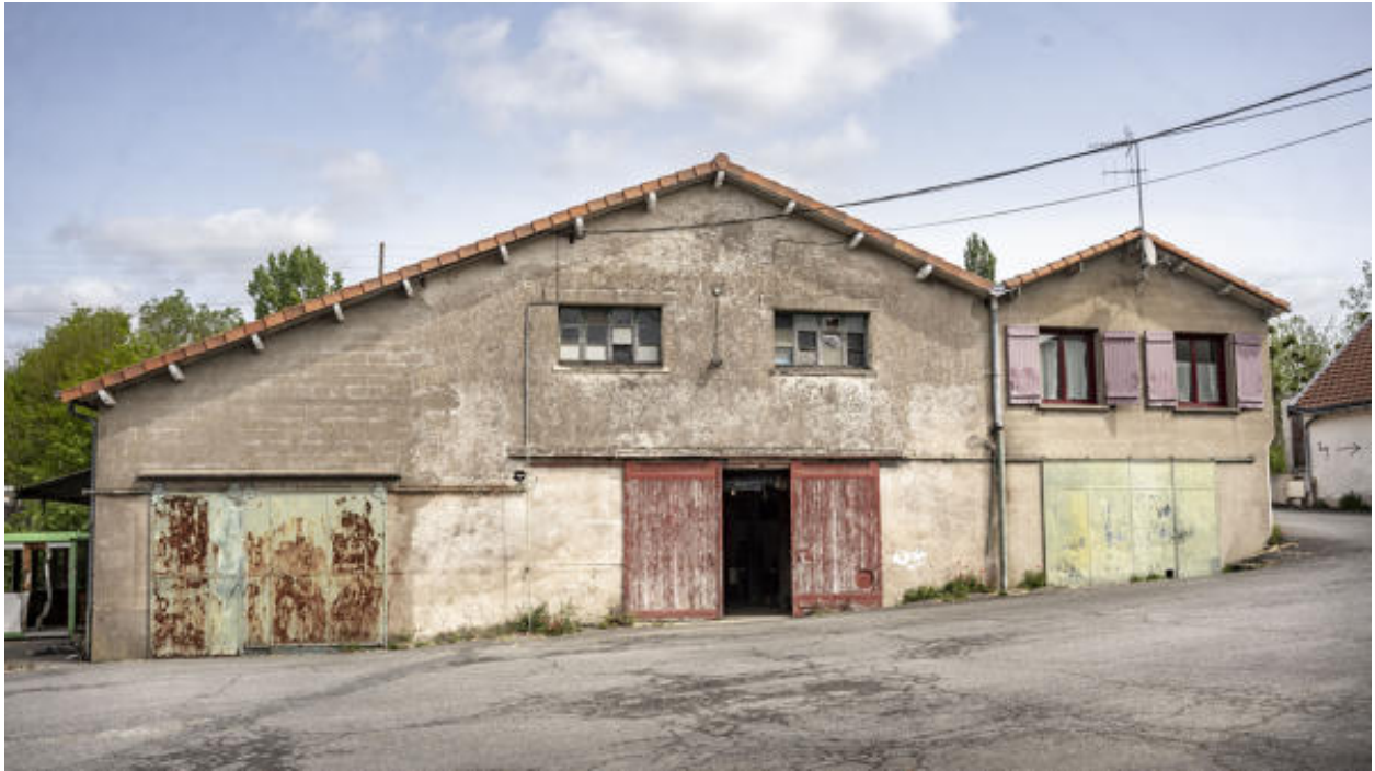
Bâtiment de stockage des bouteilles, site de la rue des Rosiers.
