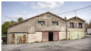
Bâtiment de stockage des bouteilles, site de la rue des Rosiers. Phot. Pierre-Bernard Fourny IVR52_20214400330NUCA
