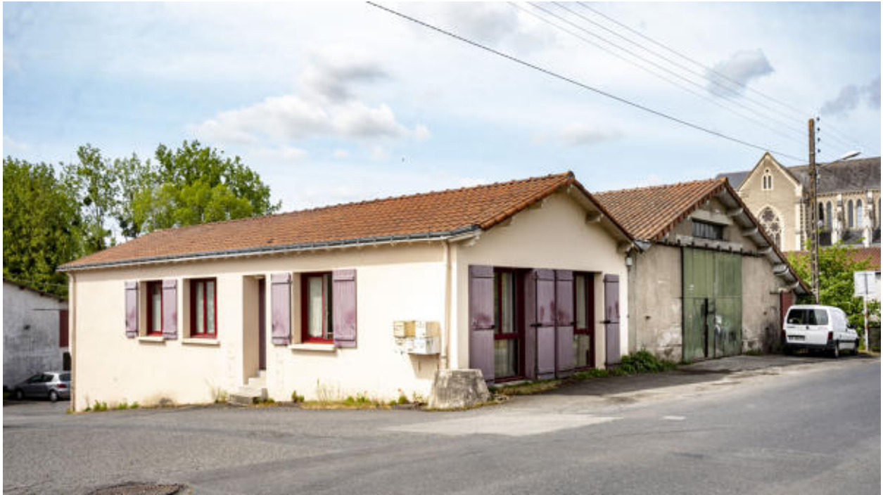
Maisons de vendangeurs, superposées à l'entrepôt de stockage des bouteilles.
