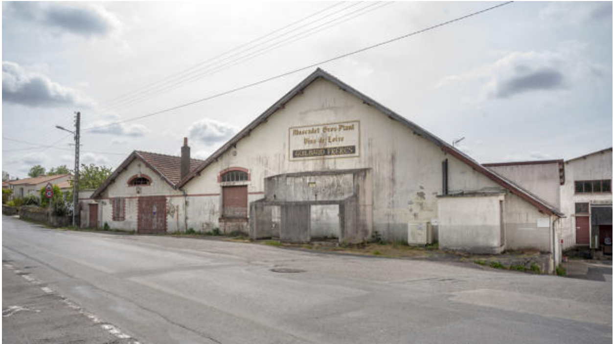
Vue générale du site de la rue des Rosiers.
