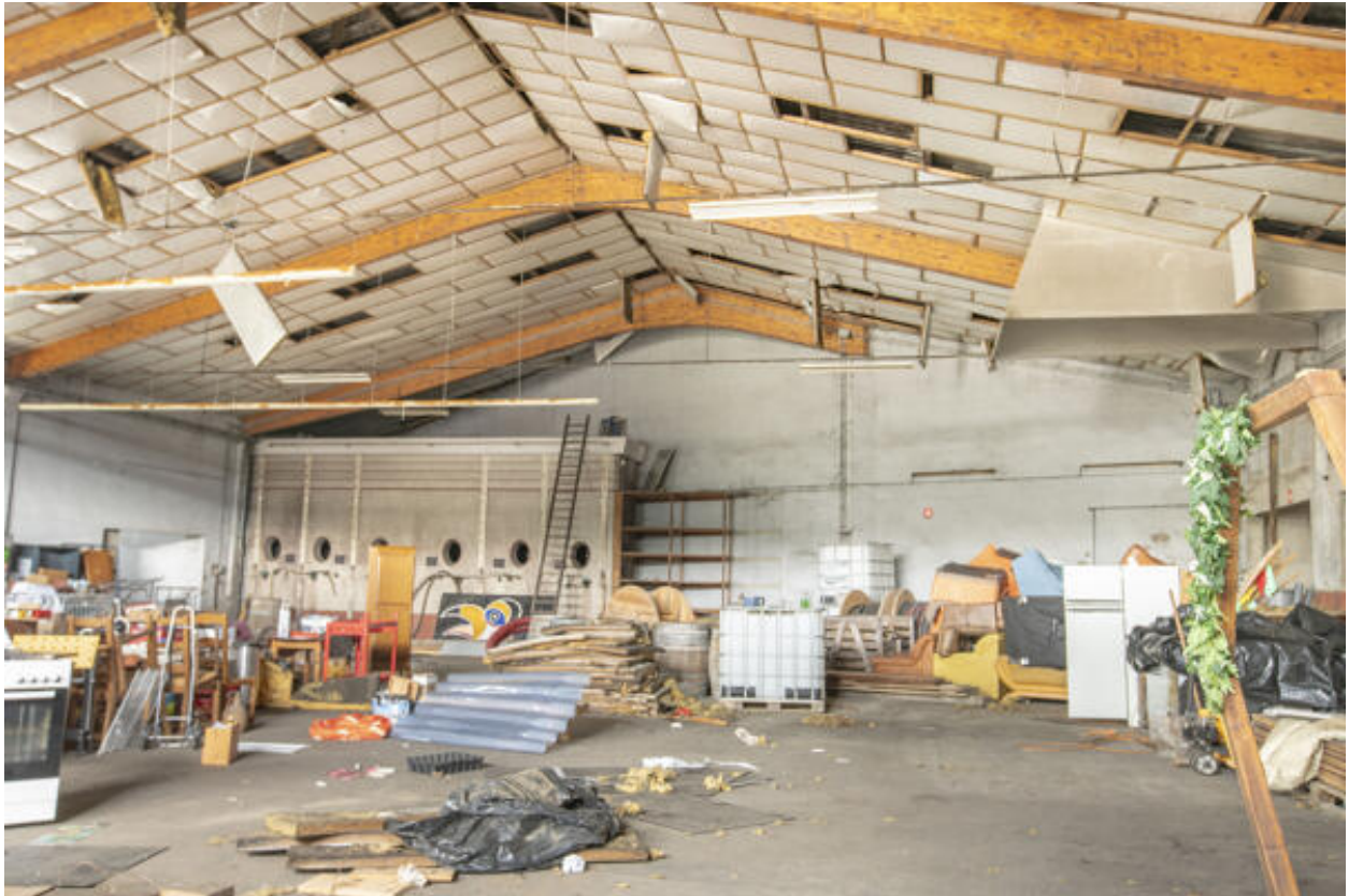
Salle de filtration et de mise en bouteille, site de la rue des Rosiers.
