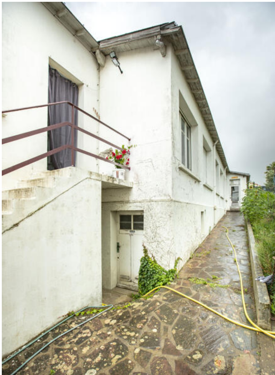
Bâtiment des bureaux, site de la rue des Rosiers.
