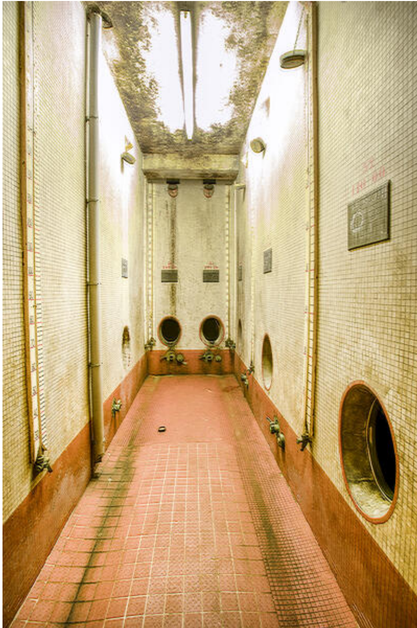
Cuverie principale, niveau inférieur.
