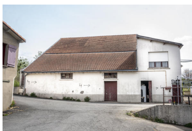
Bâtiment de filtrage et de mise en bouteille, site de la rue des Rosiers. Phot. Pierre-Bernard Fourny IVR52_20214400329NUCA
