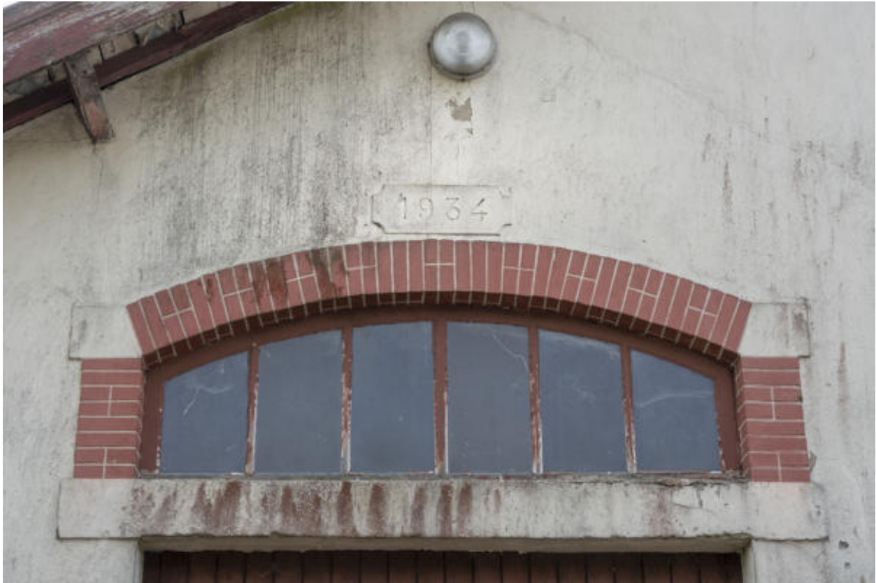
Détail du vasistas surplombant le quai.
