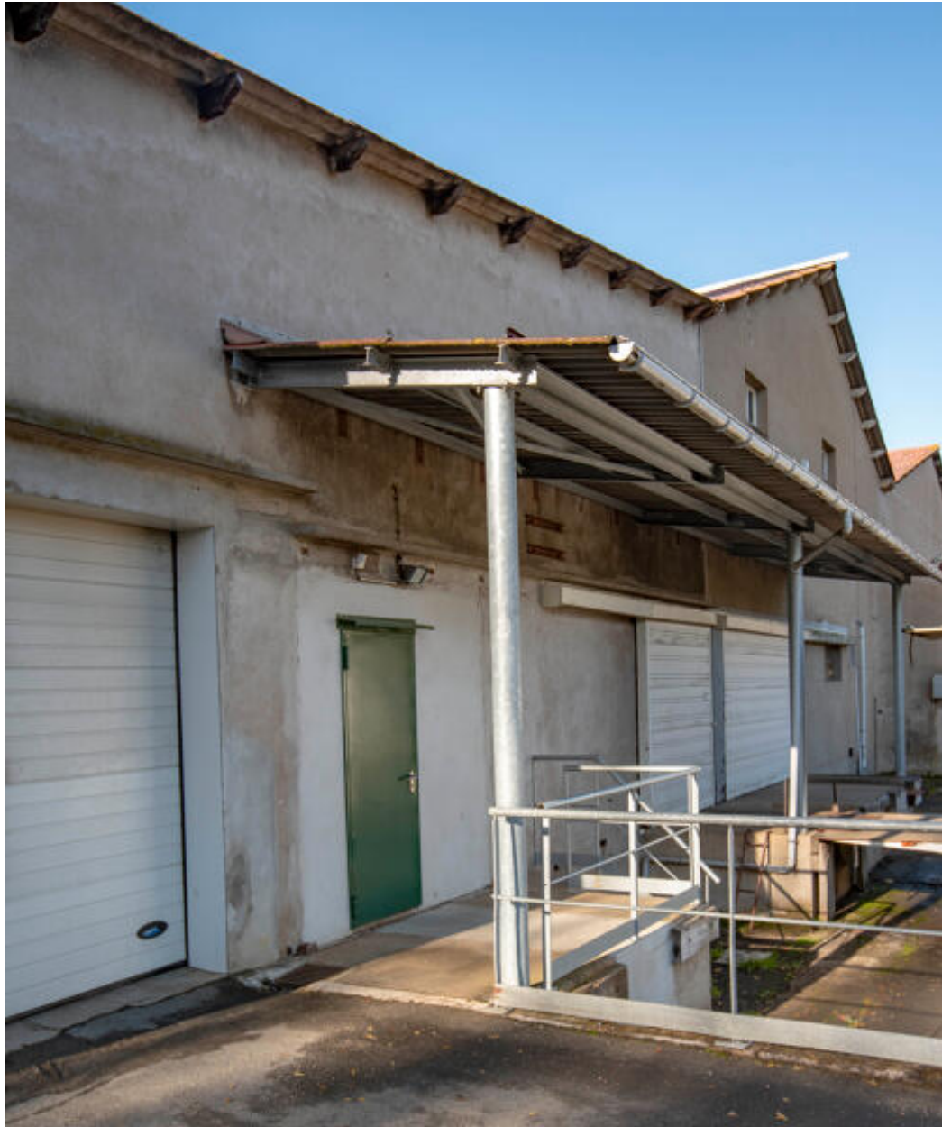
Quais de chargement, site du pont du Clos (non étudié).
