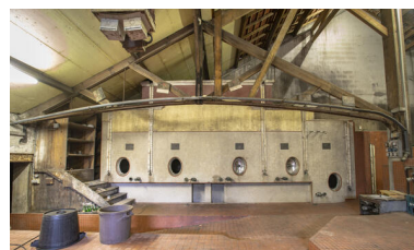
Cuverie principale, niveau supérieur. Phot. Pierre-Bernard Fourny IVR52_20224400271NUCA
