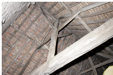
Partie centrale des anciens logis contigus : ferme de charpente nord.
