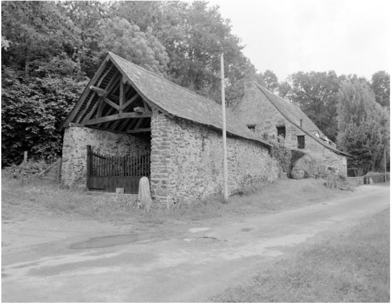
Les dépendances vues du nord : la remise et la maison de meunier.
