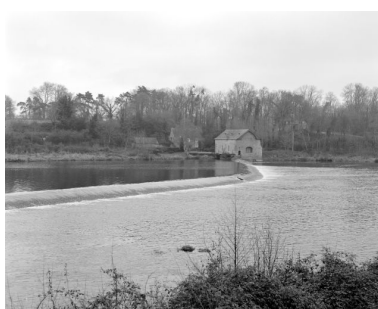
Vue d'ensemble depuis la rive droite : remise, maison du meunier, moulin (façades nord et ouest). Phot. François Lasa IVR52_20015300755X
