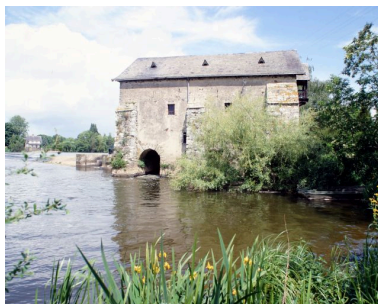
La façade sud et la sortie du coursier du large, vus d'aval. Phot. François Lasa IVR52_20025300750XA
