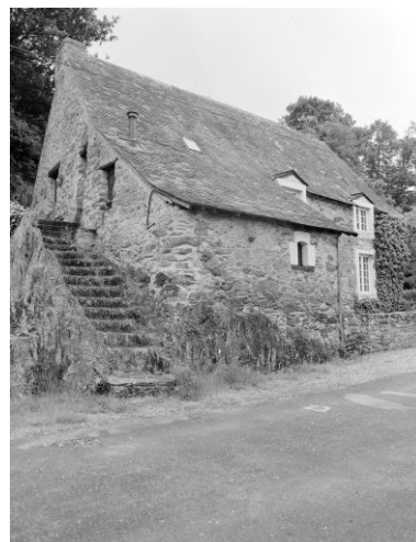
La maison de meunier. Vue depuis le nord-ouest. Phot. François Lasa IVR52_20025300721X
