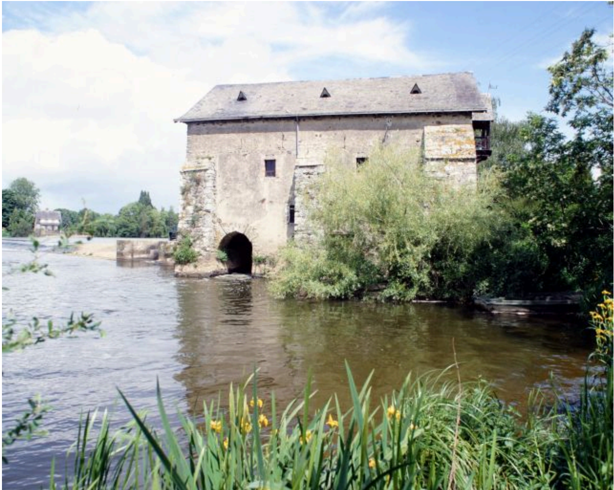
La façade sud et la sortie du coursier du large, vus d'aval.
