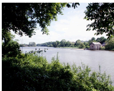
Vue d'ensemble de la vallée depuis la rive droite en aval du moulin : à droite, les façades ouest et sud du moulin et la maison de meunier ; au centre, le barrage du Gué ; au fond, le barrage de la Roche et le site du moulin de la Petite Roche (à gauche). Phot. François Lasa IVR52_20025300745XA
