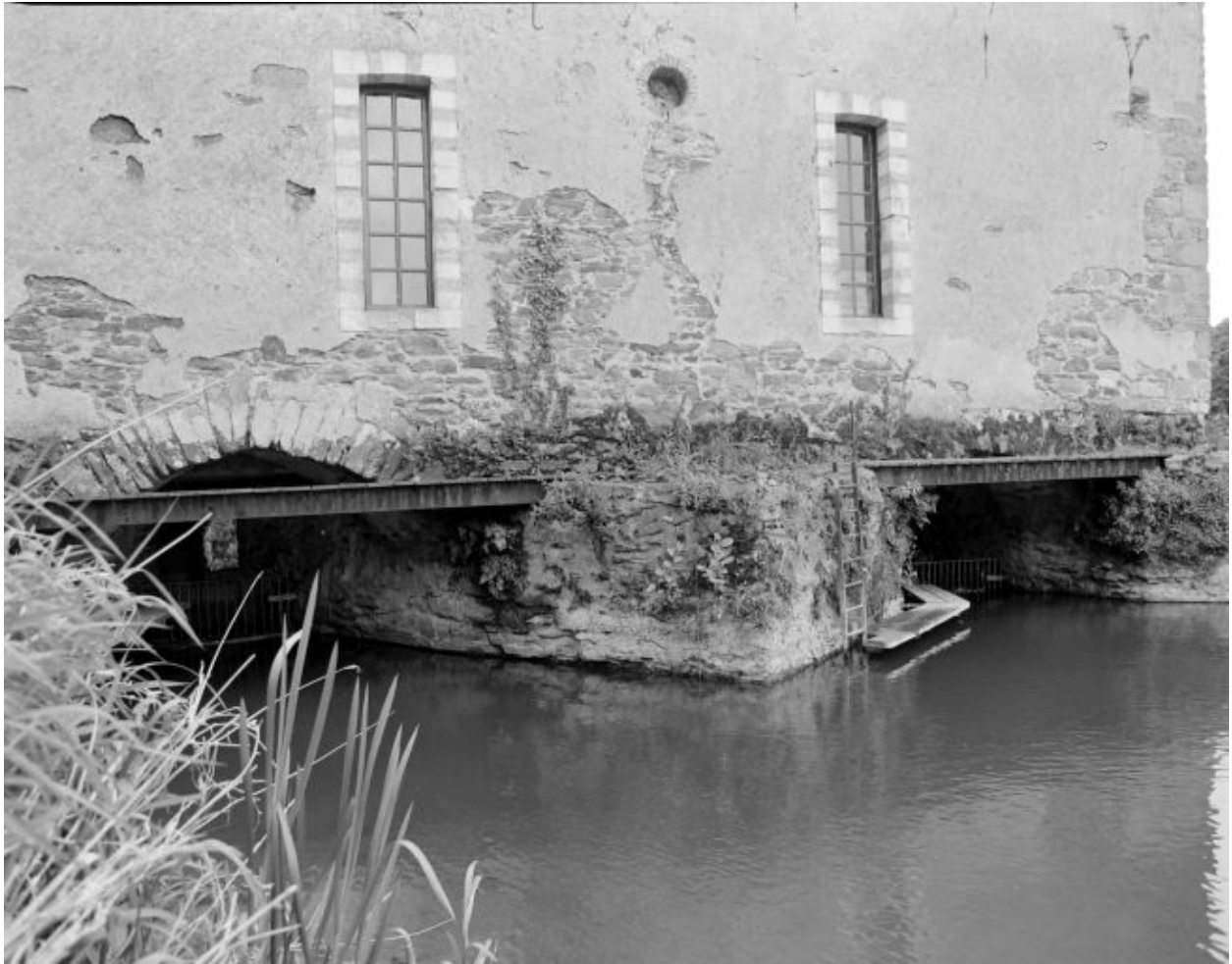
Les entrées des coursiers (en amont).
