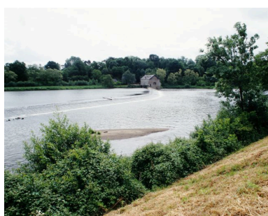
Vue d'ensemble depuis la rive droite : remise, maison du meunier, moulin (façades nord et ouest). Phot. François Lasa IVR52_20025300746XA
