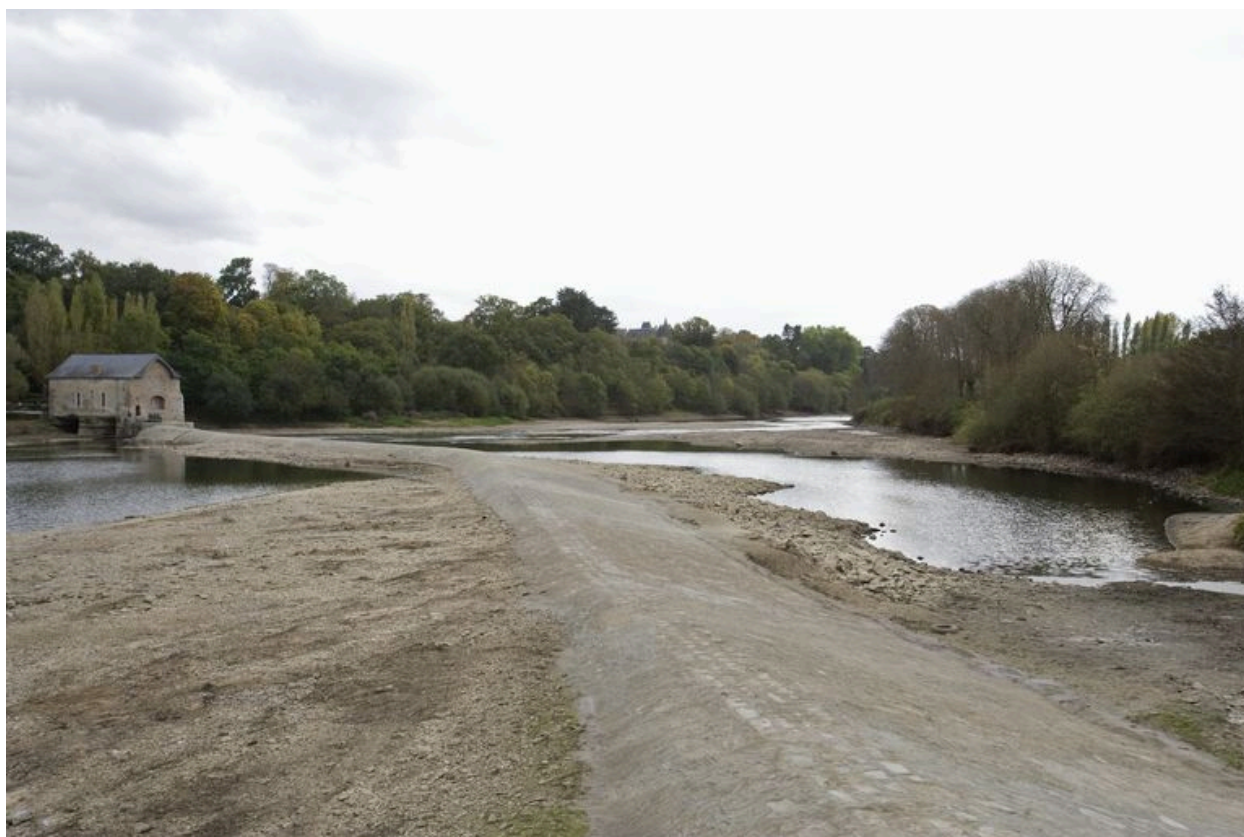
Vue d'ensemble de la vallée depuis la rive droite, pendant les écourées de 2009 : à gauche, le moulin (façades nord et ouest), au centre, le barrage.
