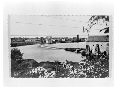
Vue d'ensemble du site de barrage du Gué depuis la rive gauche , en aval : moulin de la Gourre, barrage, pertuis, moulin du Gué (façade sud). Autr. Maurice Chrétien, Repro. François Lasa IVR52_20015300694X
