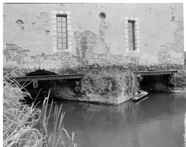
Les entrées des coursiers (en amont). Phot. François Lasa IVR52_20025300718X
