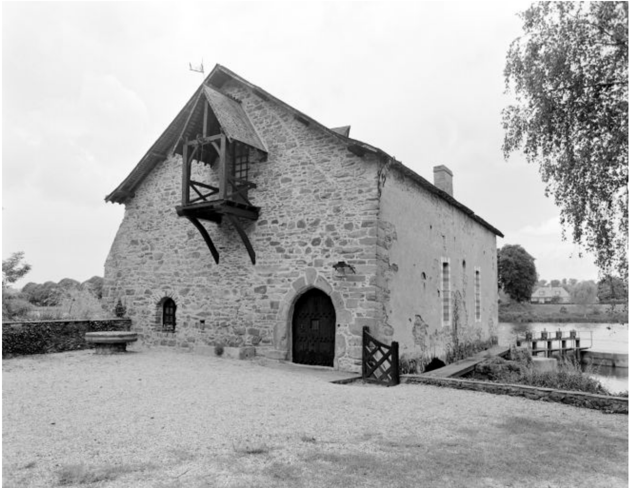
Vue depuis l'est : les façades est et nord.
