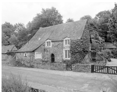
La maison de meunier. Façade principale, à l'ouest. Phot. François Lasa IVR52_20025300720X
