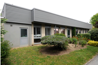
Vue des anciens locaux de l'entreprise Chupin-Immobilier, depuis le sud. Phot. Bruno Rousseau, Phot. Youenn Communeau IVR52_20114901542NUCA
