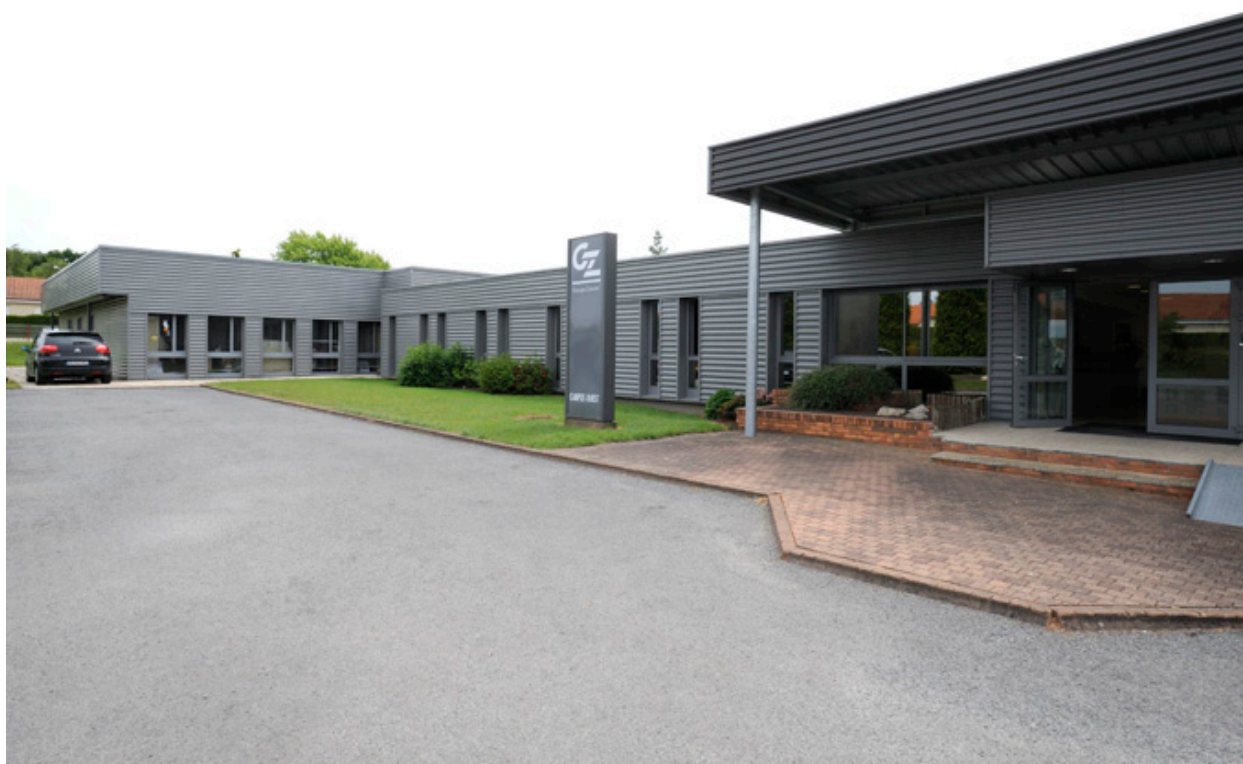
Vue des anciens locaux de l'entreprise Chupin-Immobilier, depuis le nord.
