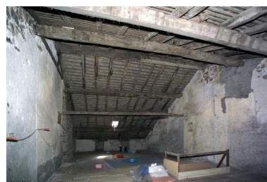
Le comble à surcroît vu en direction de la rue. Phot. Denis Pillet IVR52_20034400618NUCA
