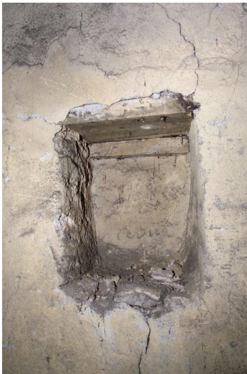
La date 1820 sur le pignon ouest
