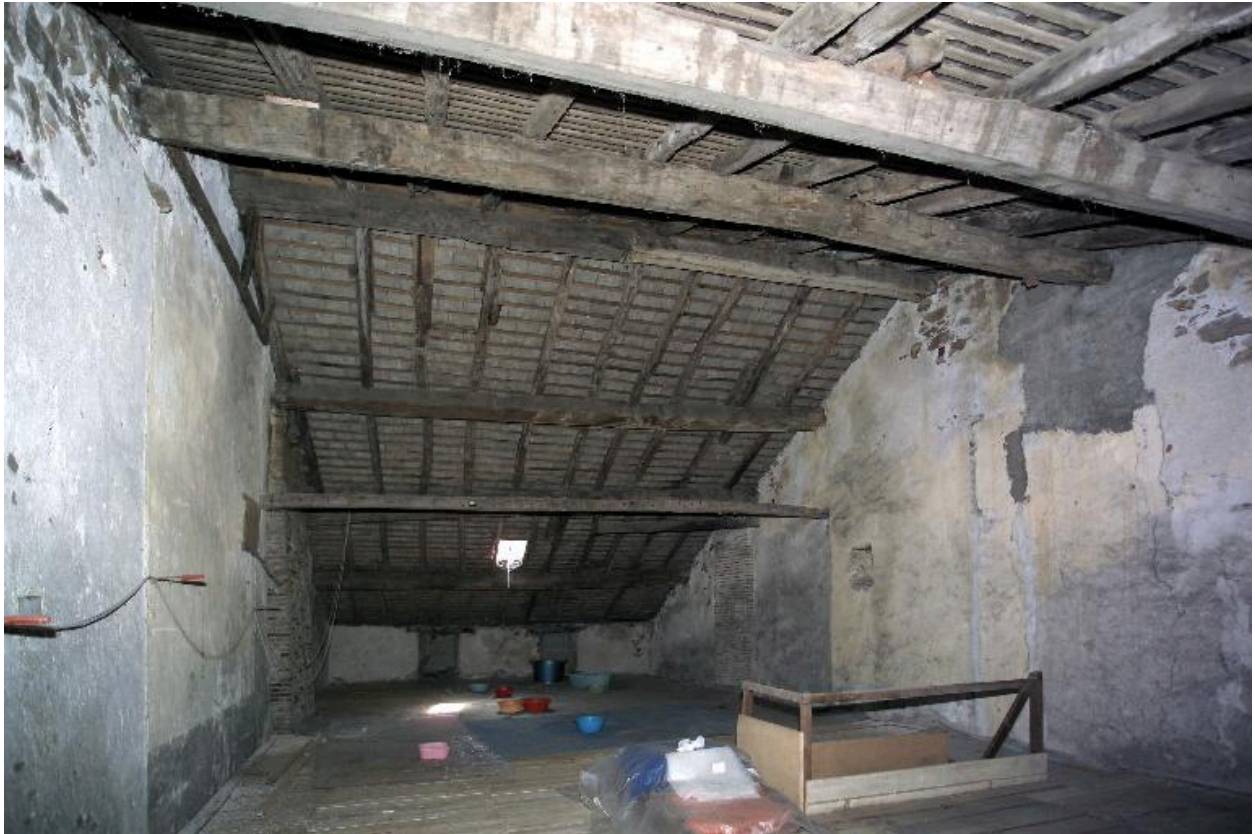
Le comble à surcroît vu en direction de la rue.
