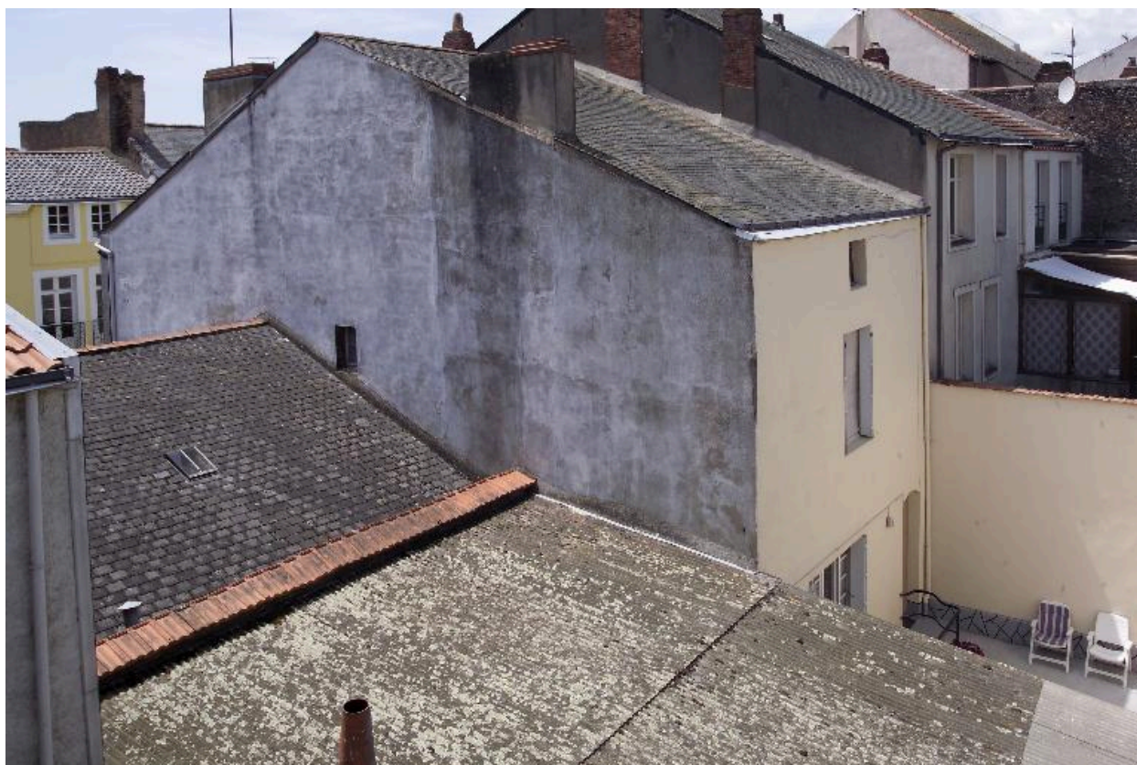
La façade postérieure vue de la maison n° 11 quai Sadi-Carnot.
