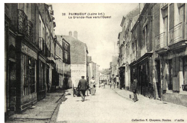
La rue du Général-De-Gaulle, 1er quart XXe siècle, à droite, la maison n° 24. Autr. Fernand Chapeau, Phot. Denis (reproduction) Pillet IVR52_20034401824NUCA
