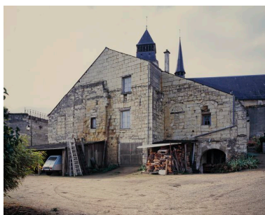
Vue générale de la façade nord, très remaniée. Phot. Bruno Rousseau IVR52_19964901739VA
