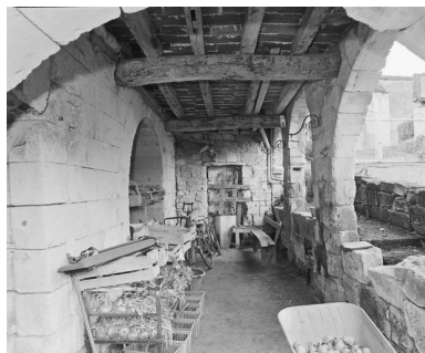
Rez-de-chaussée. Galerie ouverte sur l'ancienne cour de la Secrétainerie. Phot. Bruno Rousseau IVR52_19964901732X
