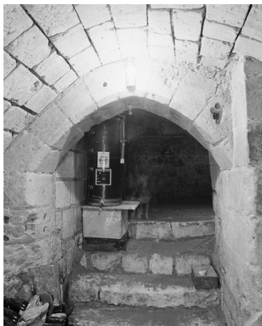
Sous-sol, porte à couverture en arc brisé et chanfreiné. Phot. Bruno Rousseau IVR52_19964901447X
