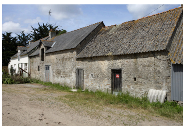
Vue d'ensemble depuis le nord-est. Phot. Denis Pillet IVR52_20084402022NUCA
