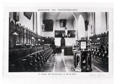
Chœur des religieuses : vu d'ensemble depuis la grille. Phot. François Lasa IVR52_20025302082X
