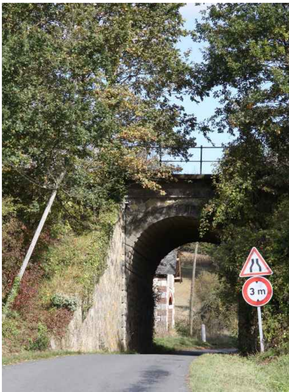
Tunnel de la D141 vers la Vallée de la Rivière.
