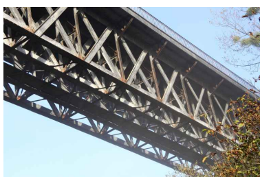
Le viaduc vu de dessous : passage à pieds sous les rails. Phot. Jean-Baptiste Darrasse IVR52_20087202491NUCA
