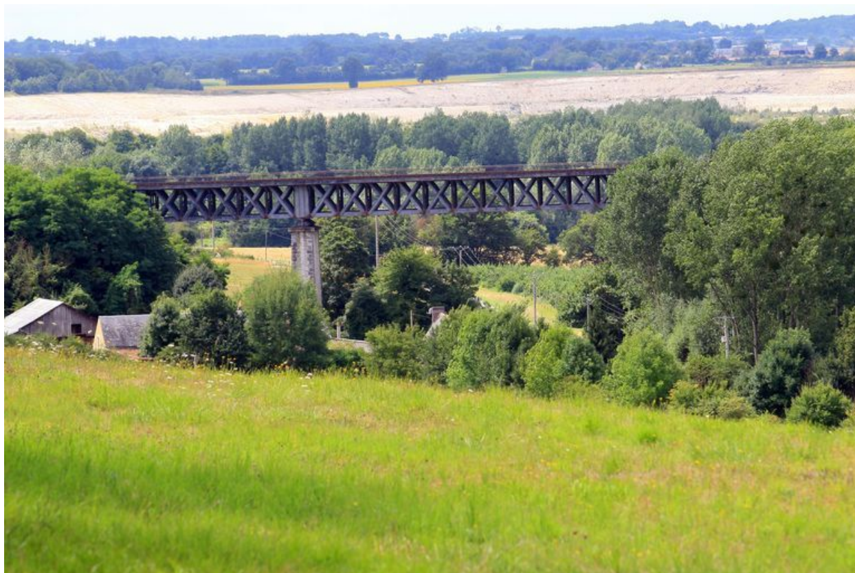
Le viaduc vu de la Fosse-Beauregard.
