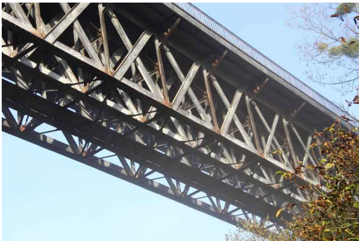
Le viaduc vu de dessous : passage à pieds sous les rails.
