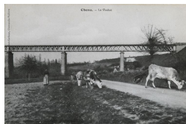
Le viaduc de Chenu pris de l'ouest. Phot. Jean-Baptiste (reproduction) Darrasse IVR52_20067207207NUCA
