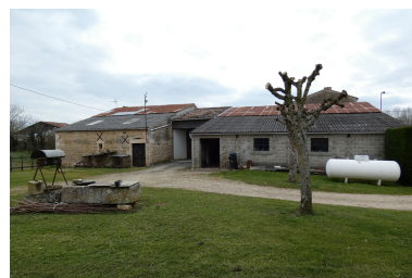
Les dépendances au nord vues depuis le nord. Phot. Yannis Suire IVR52_20238500853NUCA
