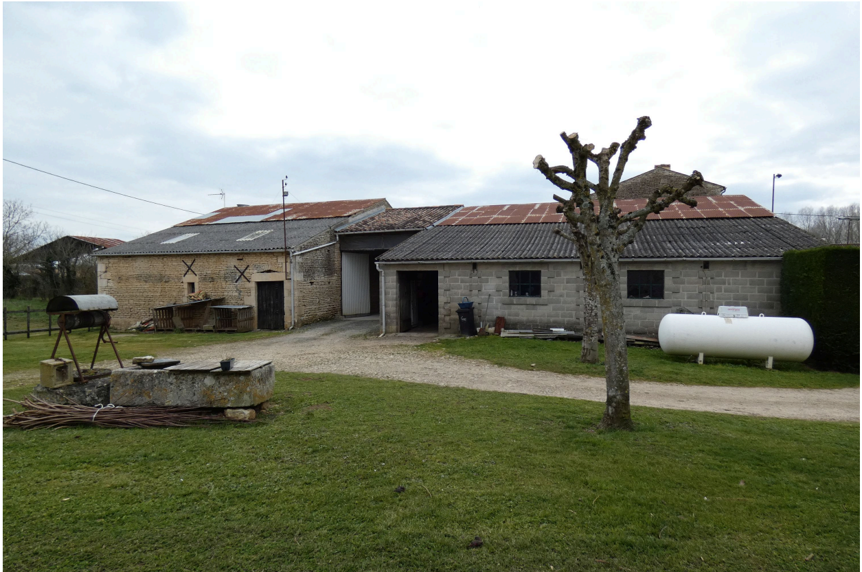
Les dépendances au nord vues depuis le nord.
