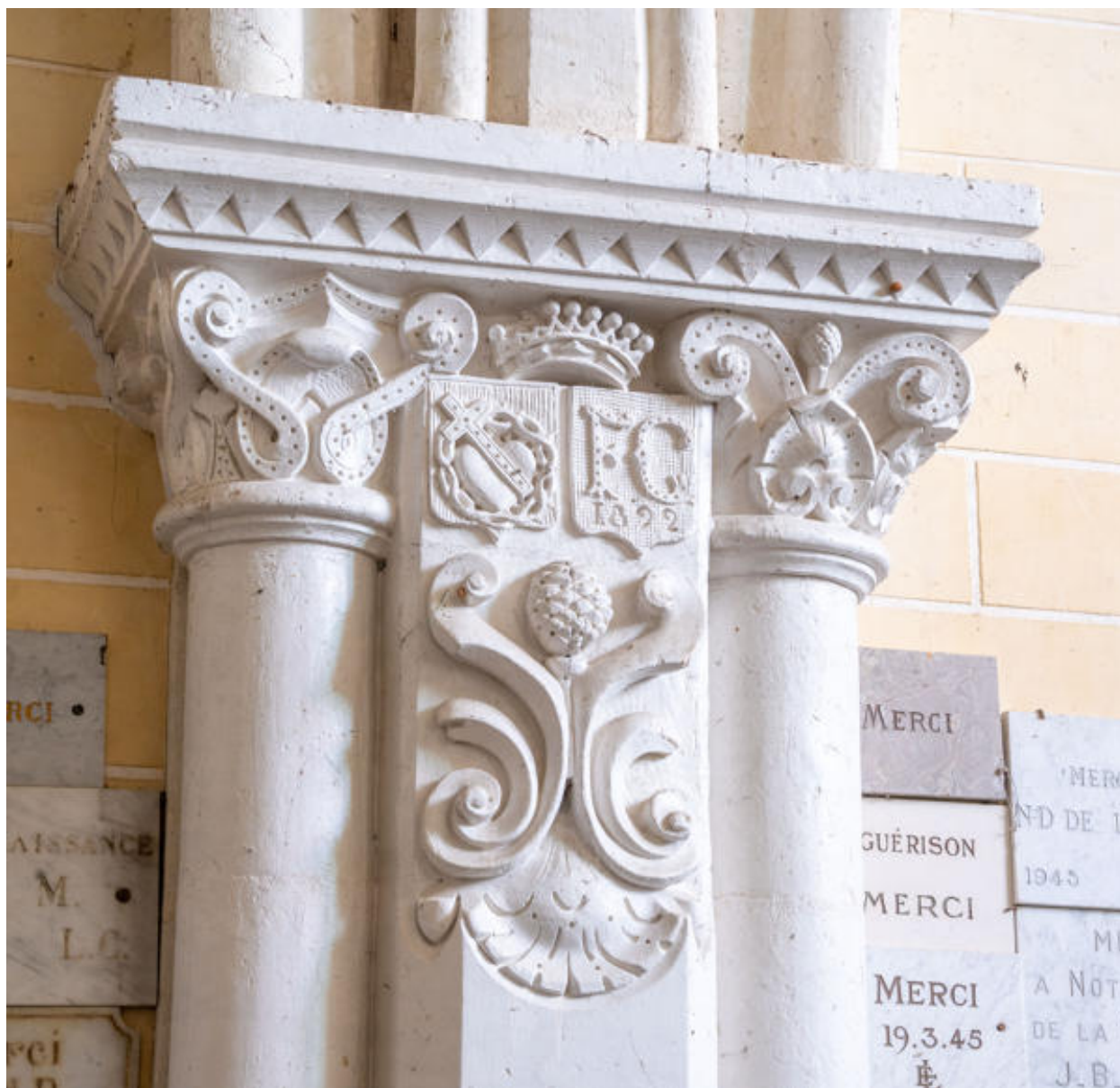
Un détail d'un pilier engagé supportant les voûtes.
