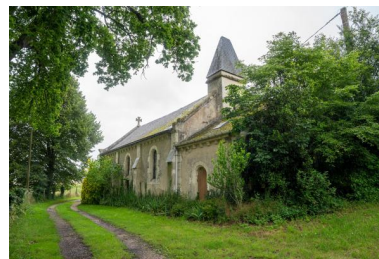
La chapelle depuis le sud-est. Phot. Pierre-Bernard Fourny IVR52_20215300364NUCA
