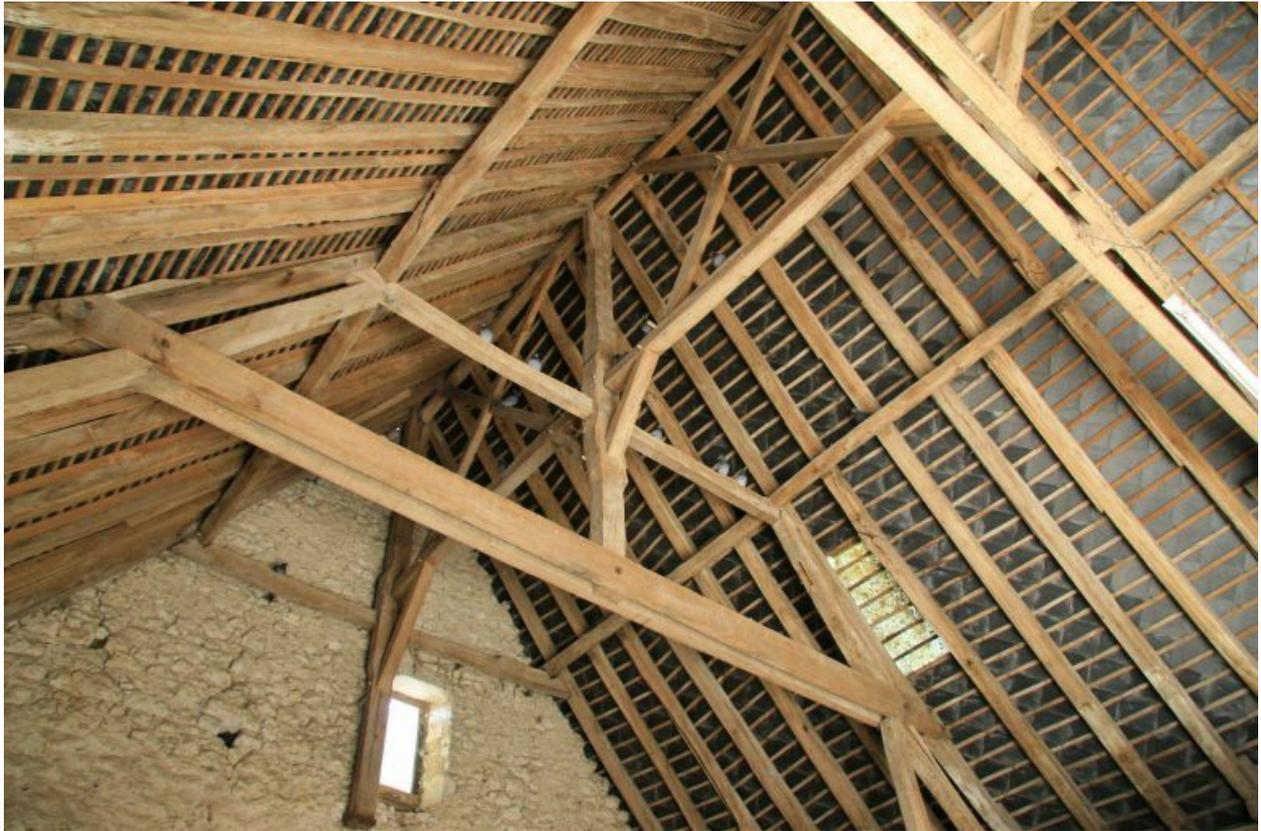
La grange : la charpente à sous-faîtage et faux entrails à encoches renforcés.
