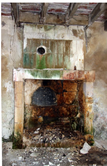
Logement La Roussière, salle centrale : cheminée avec four à pain. Phot. Jean-Baptiste Darrasse IVR52_20087201972NUCA
