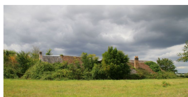
Logement, La Roussière, vue d'ensemble prise depuis le nord-est. Phot. Jean-Baptiste Darrasse IVR52_20087201975NUCA
