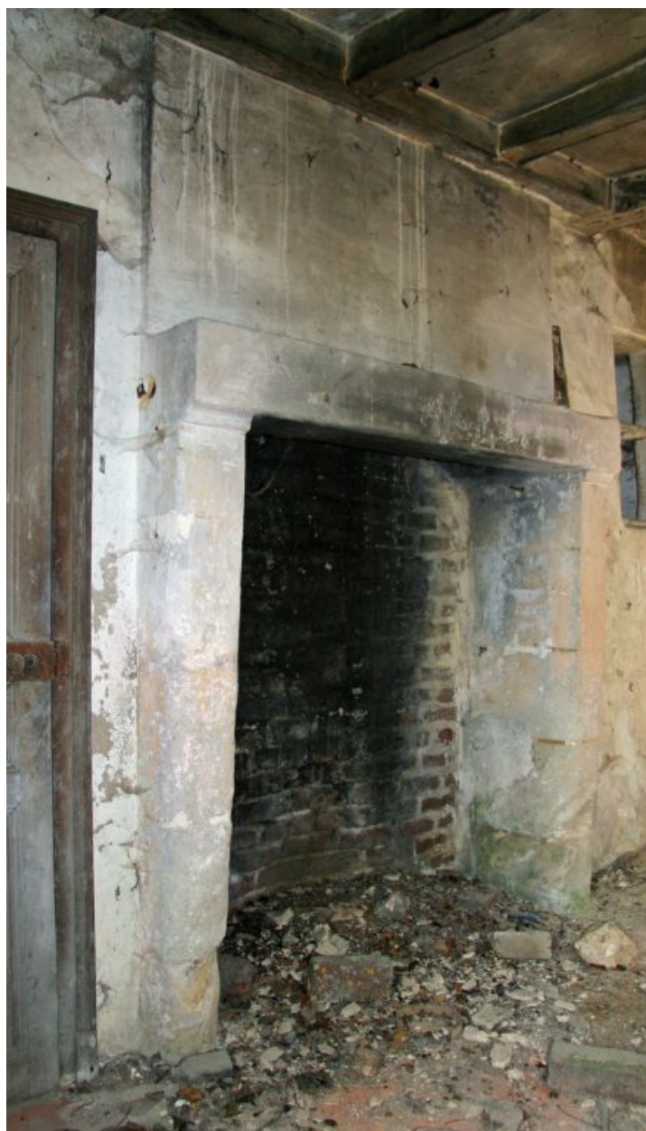
Logement La Roussière, salle nord : cheminée.
