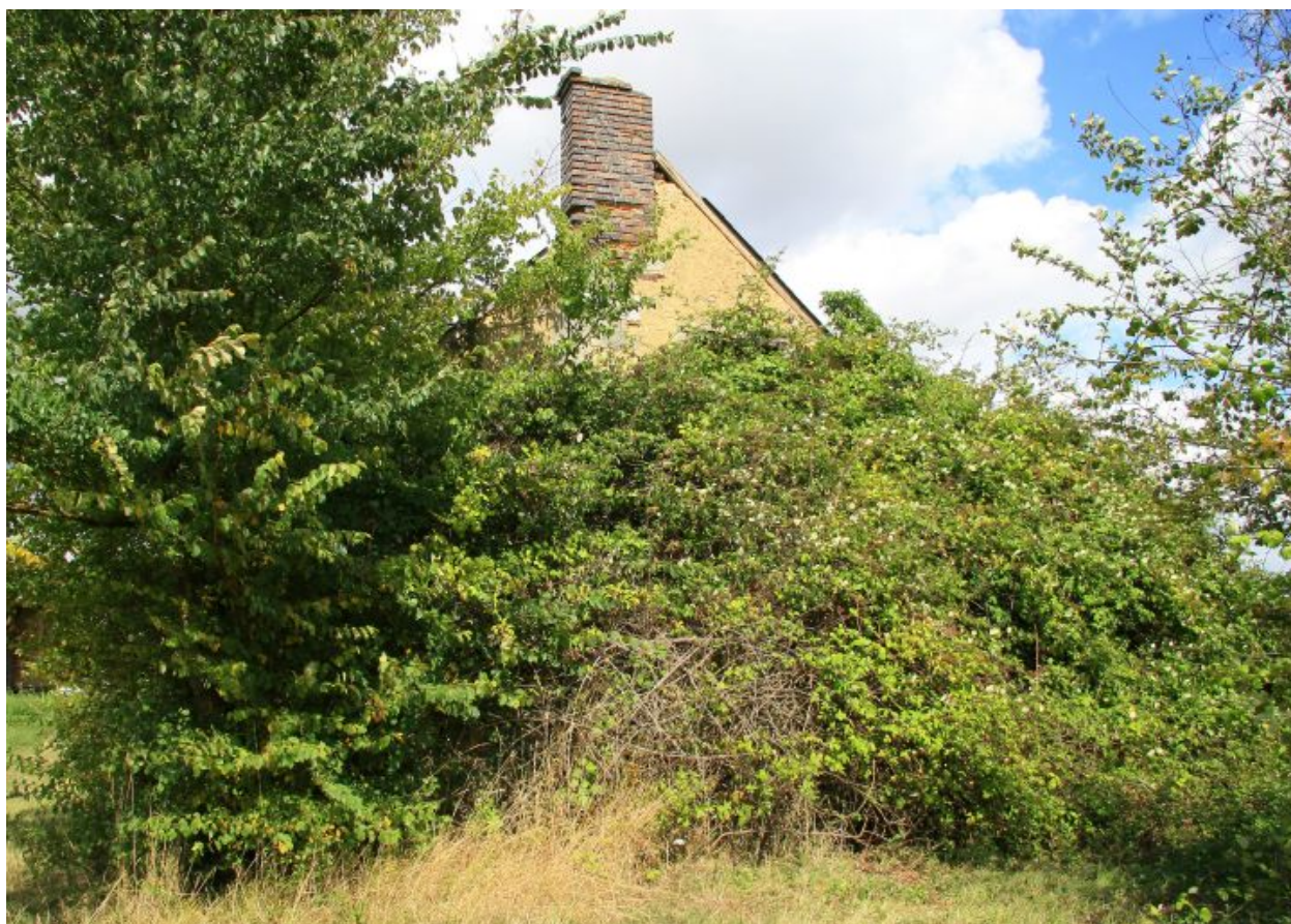
Logement La Roussière, pignon sud avec souche de cheminée.
