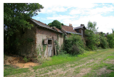
Logement La Roussière, façade antérieure sur le chemin. Phot. Jean-Baptiste Darrasse IVR52_20087201974NUCA
