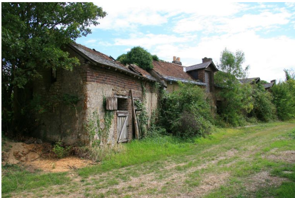
Logement La Roussière, façade antérieure sur le chemin.
