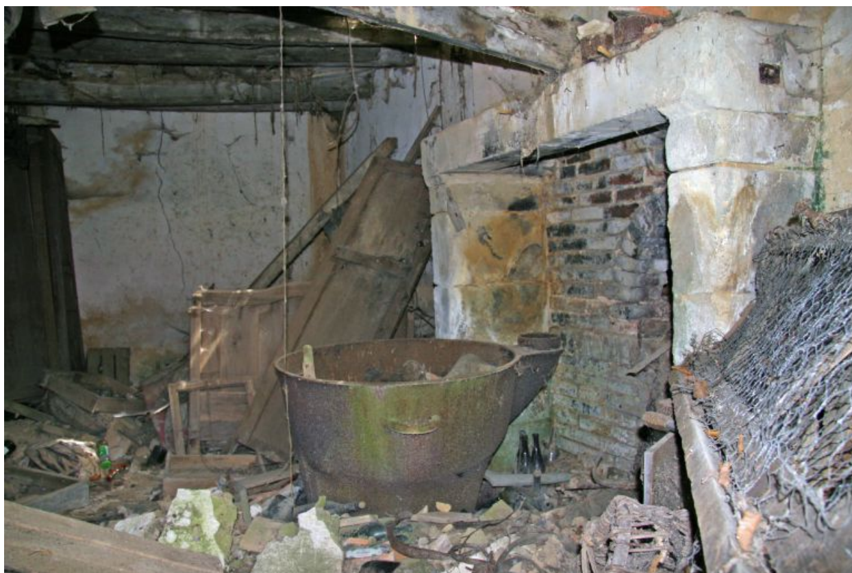
Logement La Roussière, cheminée de la salle sud transformée en buanderie.
