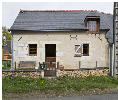
La maison. Phot. Pierre-Bernard Fourny IVR52_20147200246NUCA
