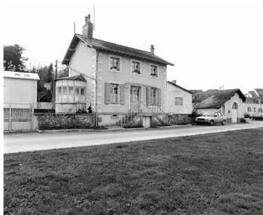
La maison éclusière. Phot. François Lasa IVR52_20015300743X
