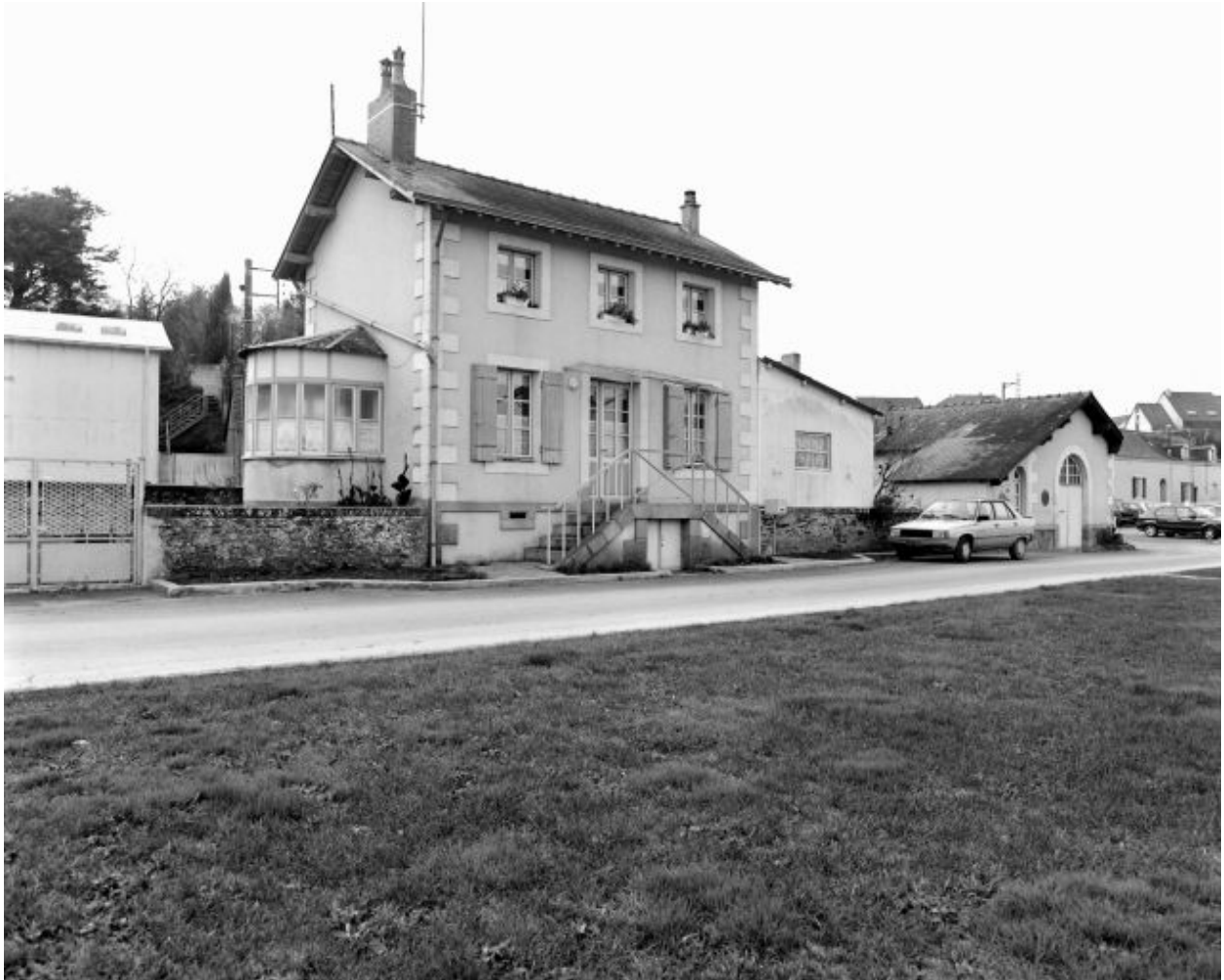
La maison éclusière.
