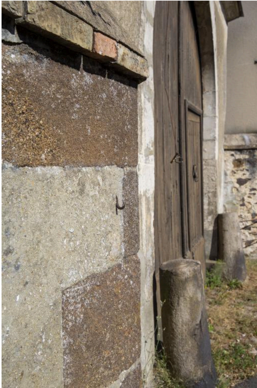
Grès roussard en chaîne d'angle sur le portail d'entrée rue du Pavé.
