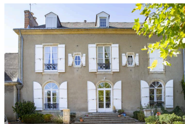
Vue de la façade principale de la maison. Phot. Pierre-Bernard Fourny IVR52_20197202228NUCA
