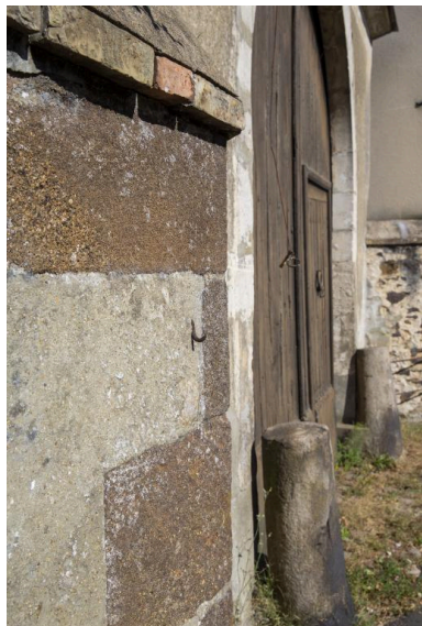
Grès roussard en chaîne d'angle sur le portail d'entrée rue du Pavé. Phot. Pierre-Bernard Fourny IVR52_20197202223NUCA
