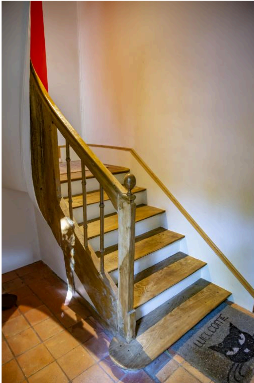
Vue de l'escalier du pavillon latéral depuis le rez-de-chaussée.
