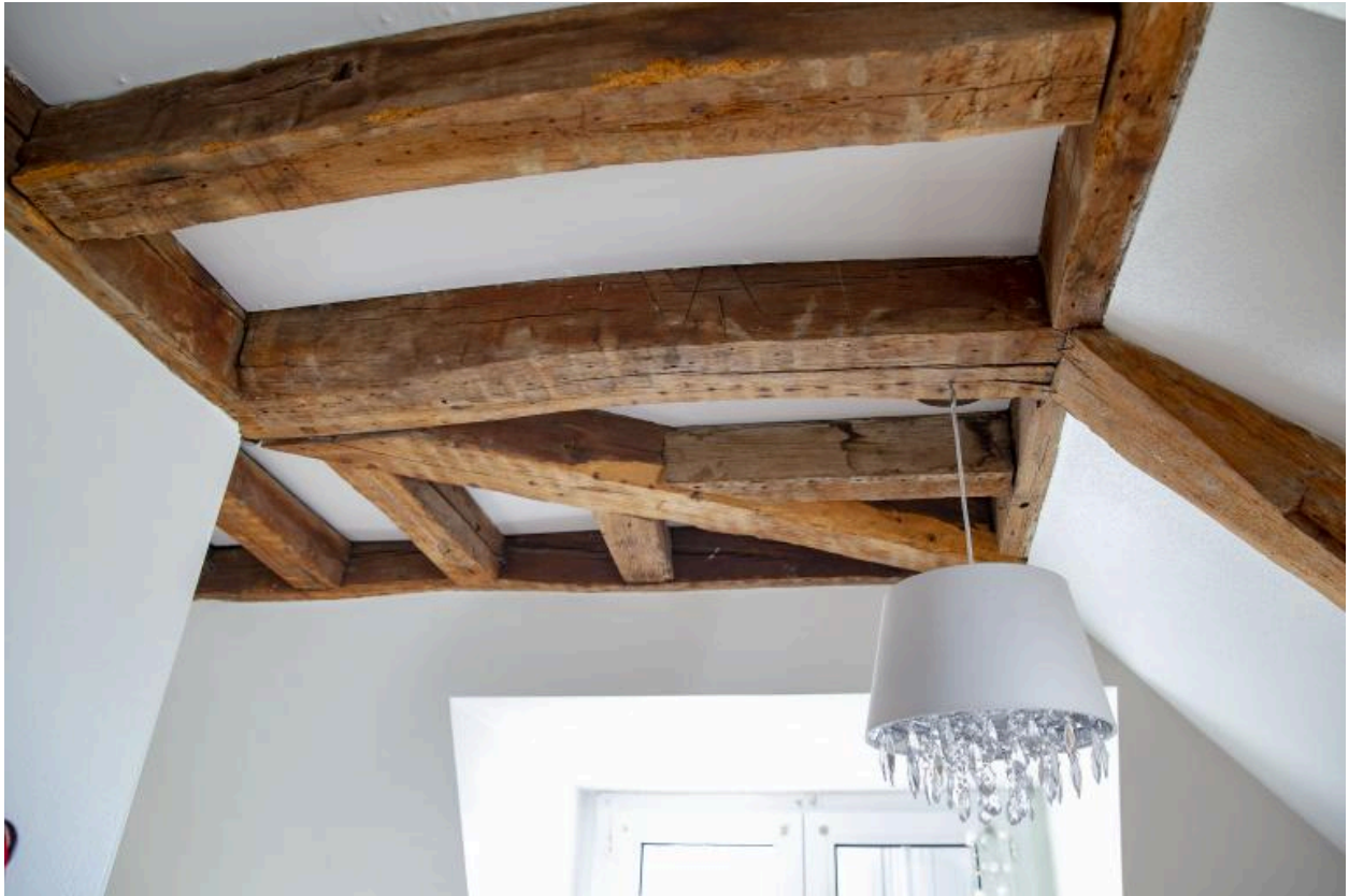
Vue des éléments de l'enrayure de la charpente.
