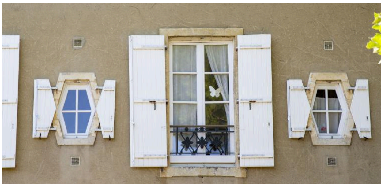
Travées centrales du premier étage sur la façade principale.
