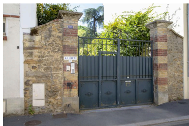
Portail d'entrée rue Kléber. Phot. Pierre-Bernard Fourny IVR52_20197202226NUCA
