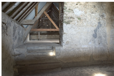
Vue du comble du logis depuis la partie sud-est. Phot. François Lasa IVR52_20045302578NUCA
