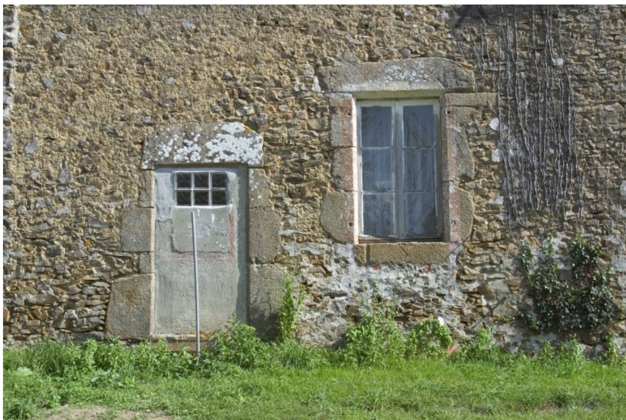
Façade principale du logis : la partie centrale.
