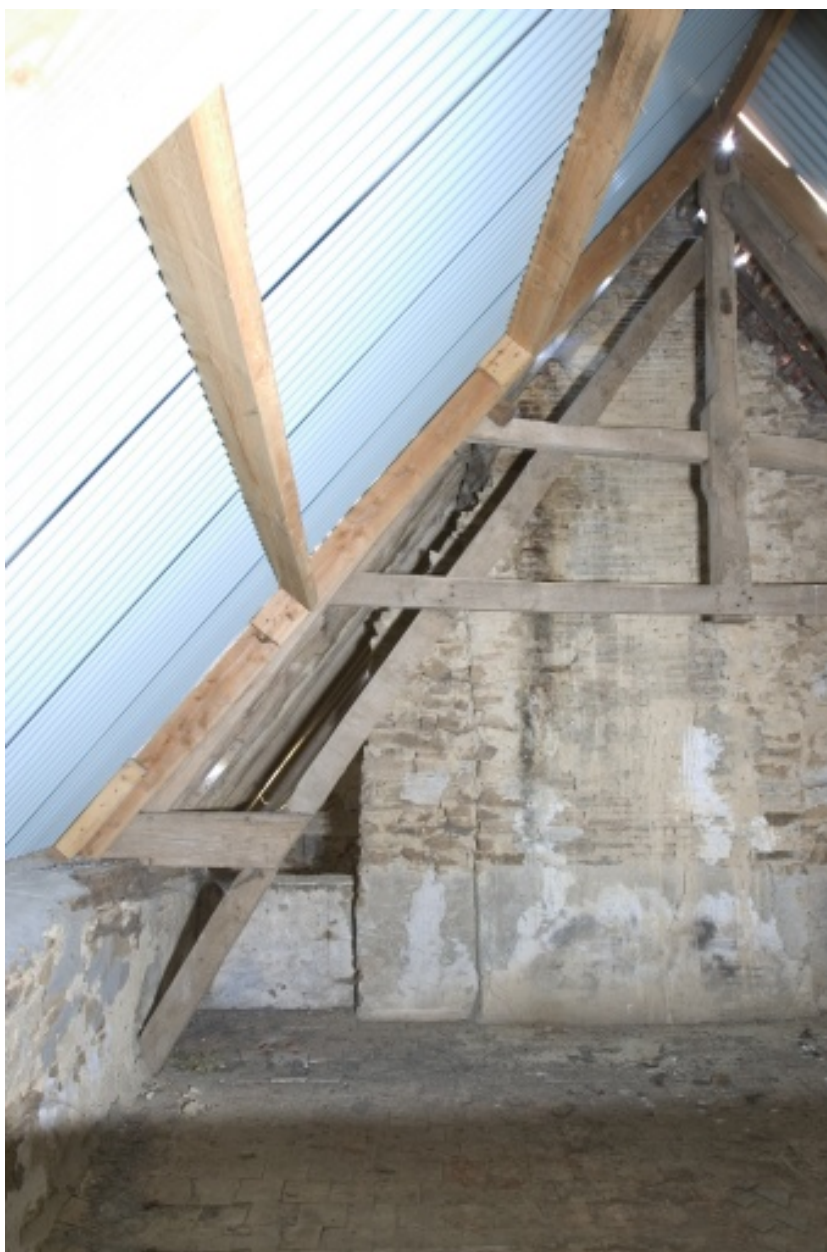
La charpente du logis : ferme ancienne (remaniée au 20e siècle) de la partie centrale.
