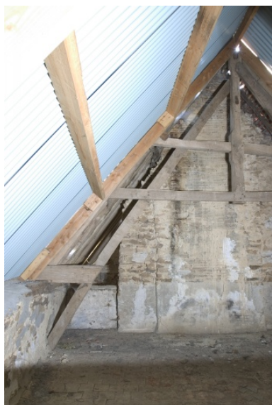
La charpente du logis : ferme ancienne (remaniée au 20e siècle) de la partie centrale. Phot. François Lasa IVR52_20045302577NUCA
