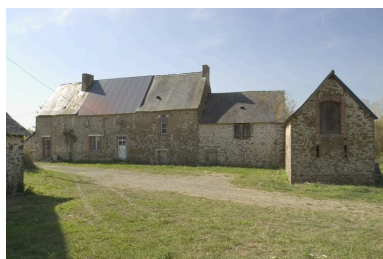
La façade postérieure du logis et la porcherie vues depuis le nord-est. Phot. François Lasa IVR52_20045302570NUCA
