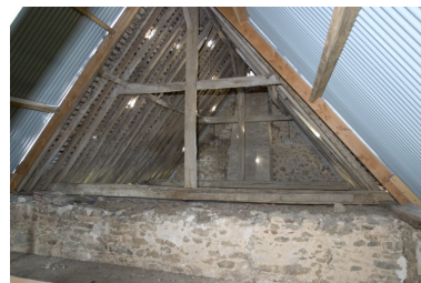
La charpente du logis : partie nord-ouest. Phot. François Lasa IVR52_20045302576NUCA
