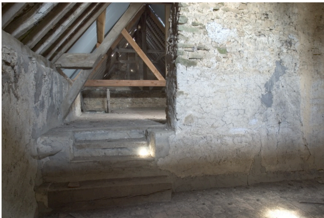
Vue du comble du logis depuis la partie sud-est.
