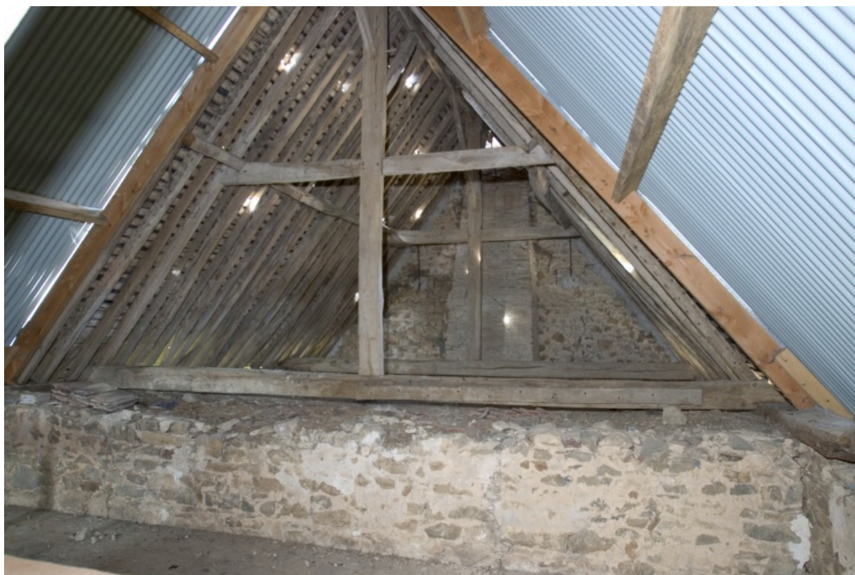
La charpente du logis : partie nord-ouest.
