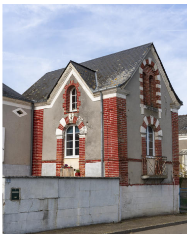
L'aile en retour. Phot. Pierre-Bernard Fourny IVR52_20225300254NUCA
