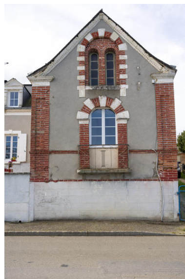
L'aile en retour. Phot. Pierre-Bernard Fourny IVR52_20225300252NUCA
