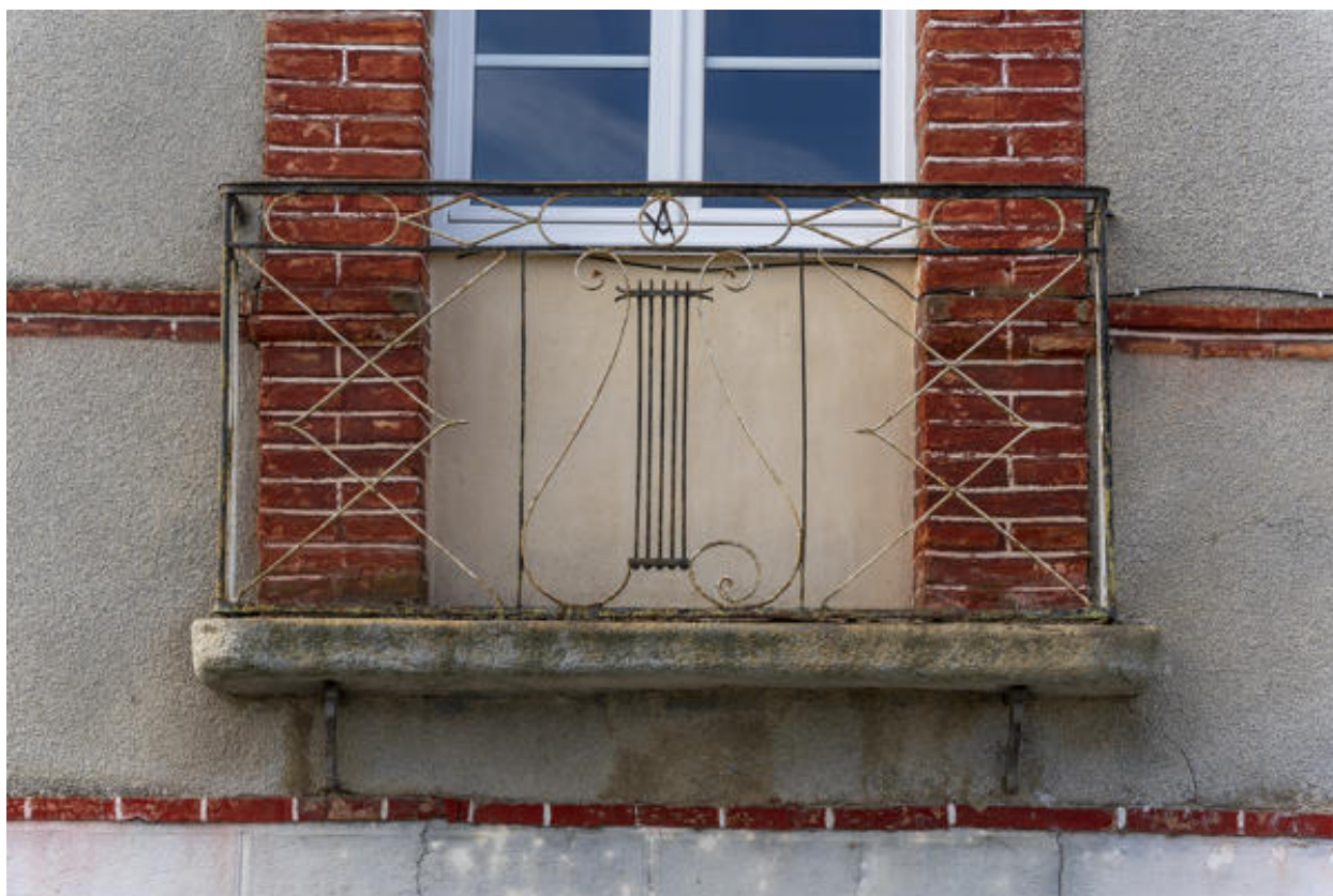
Un détail du balcon.
