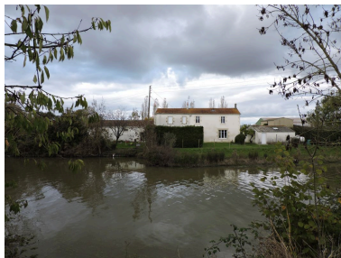
L'ancienne ferme, au bord du canal, vue depuis le sud. Phot. Yannis Suire IVR52_20198503186NUCA
