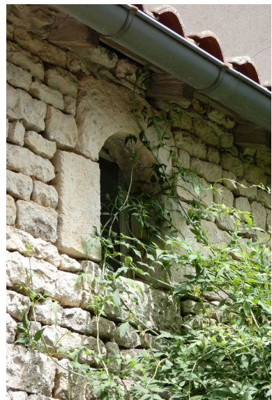
Petite baie en arc en plein cintre sur la partie ouest de la maison.
