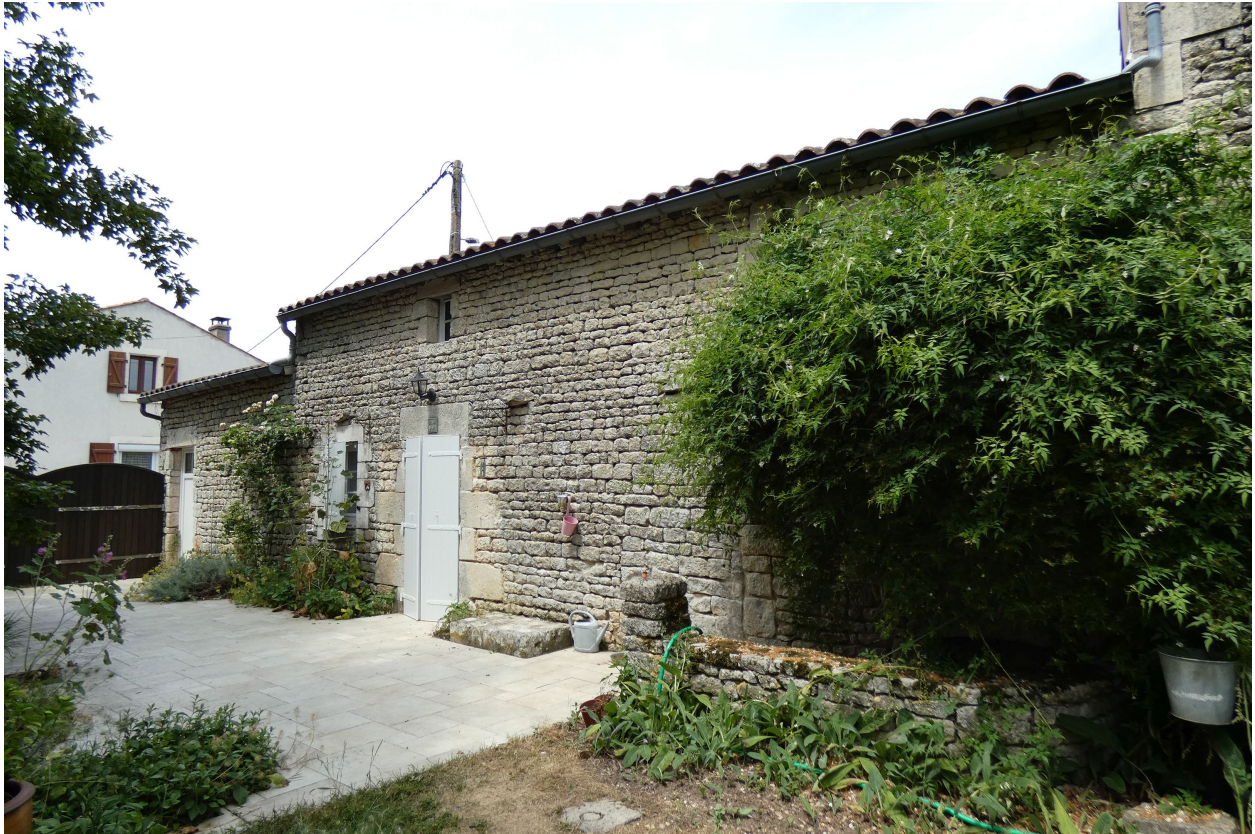
La partie ouest de la maison.
