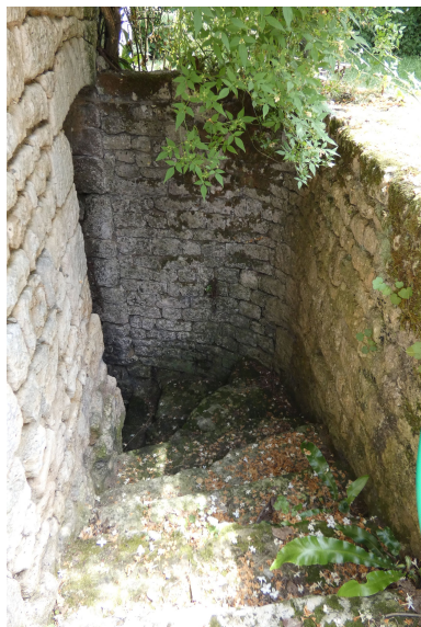
La descente de la cave sous la partie ouest de la maison. Phot. Yannis Suire IVR52_20238502059NUCA
