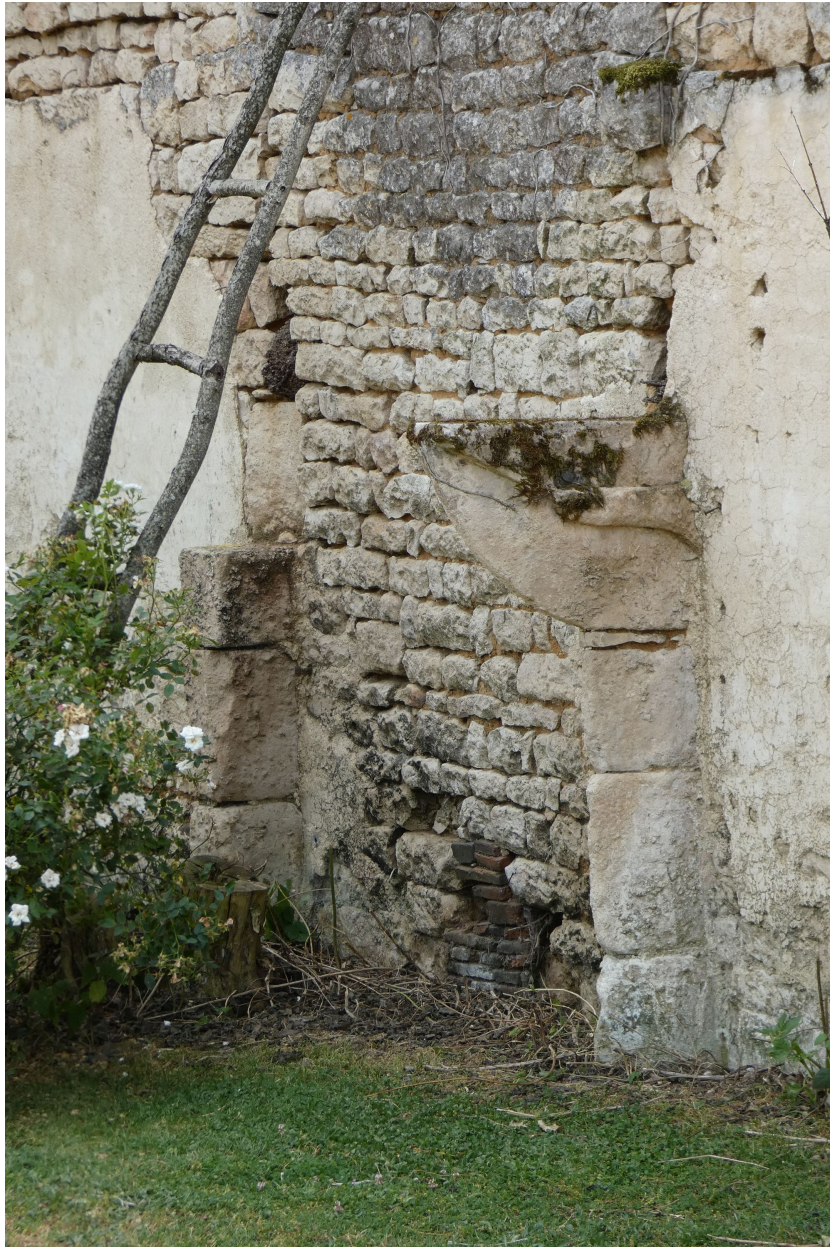
Vestiges de cheminée de la maison disparue au nord-est.
