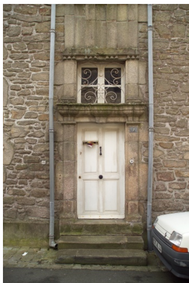
Détail de la travée centrale. Phot. Denis Pillet IVR52_20074400440NUCA
