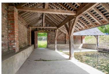
L'intérieur du lavoir. Phot. Pierre-Bernard Fourny IVR52_20197200936NUCA
