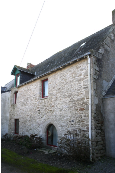
Vue de la façade nord. Phot. Denis Pillet IVR52_20084400223NUCA
