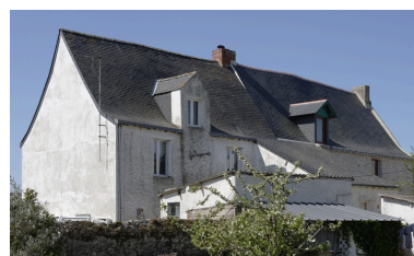
Vue d'ensemble depuis le nord-est. Phot. Denis Pillet IVR52_20104401047NUCA
