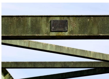
Détail de la plaque du pont René-Trottier. Phot. Armelle Maugin IVR52_20254900229NUCA
