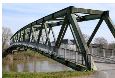
Vue d'ensemble du pont René-Trottier. Phot. Armelle Maugin IVR52_20254900227NUCA
