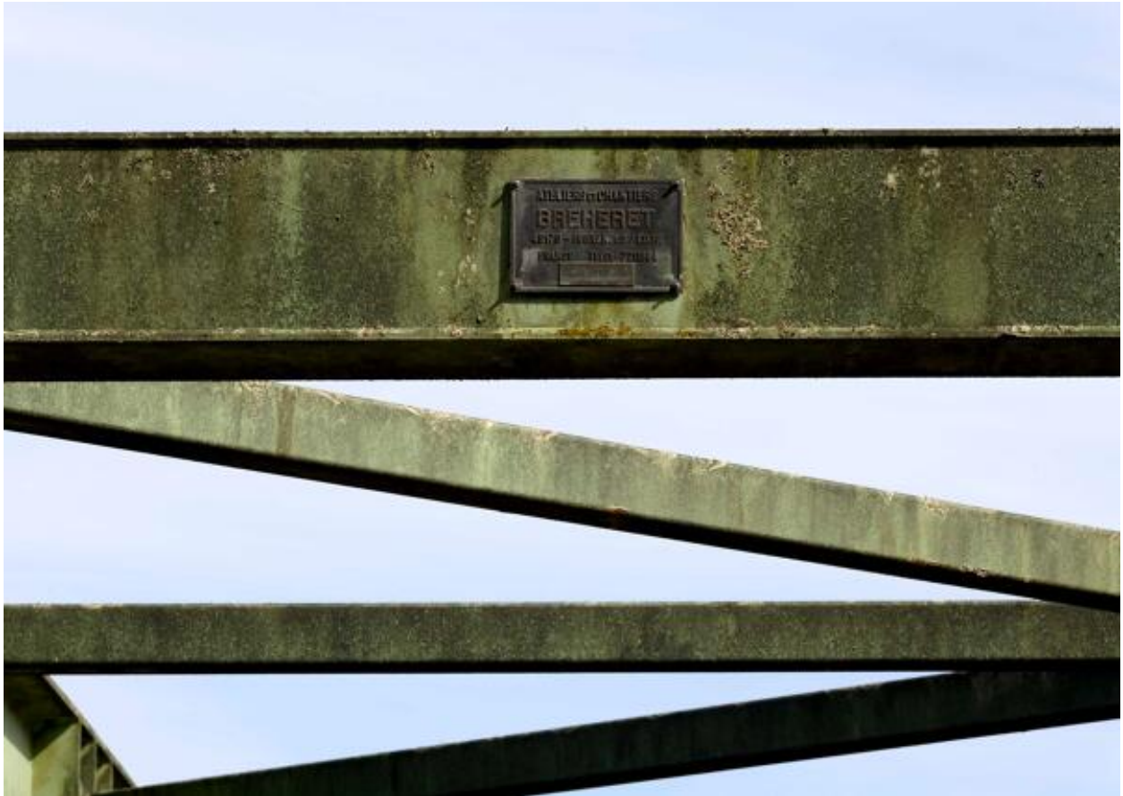
Détail de la plaque du pont René-Trottier.
