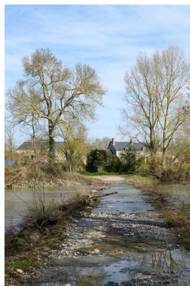
Vue d'ensemble de la digue donnant accès à l'île de la Guesse. Phot. Armelle Maugin IVR52_20254900236NUCA
