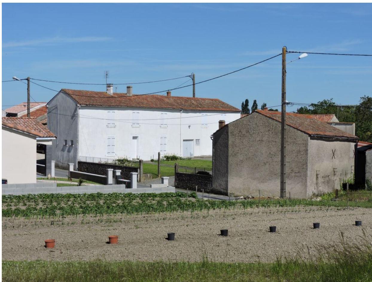
L'ancienne ferme vue depuis l'ouest.
