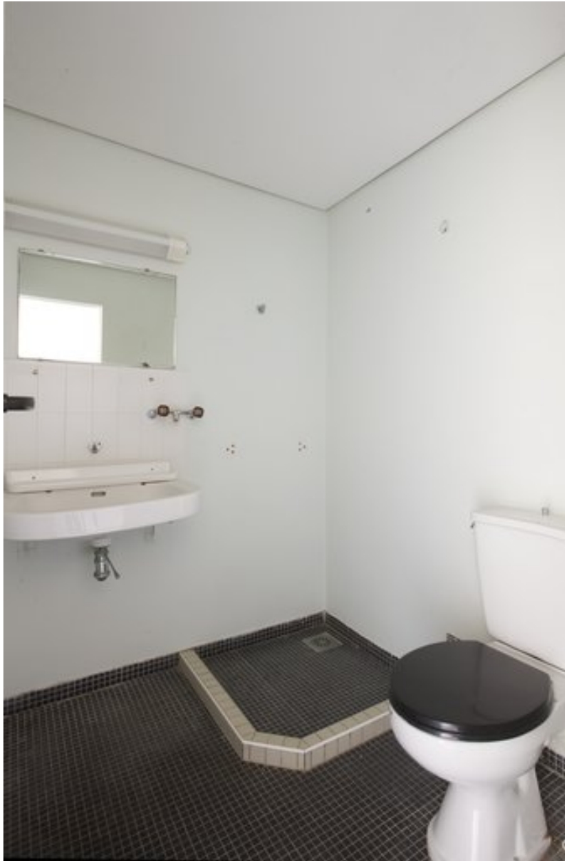
Salle de douche d'une chambre.
