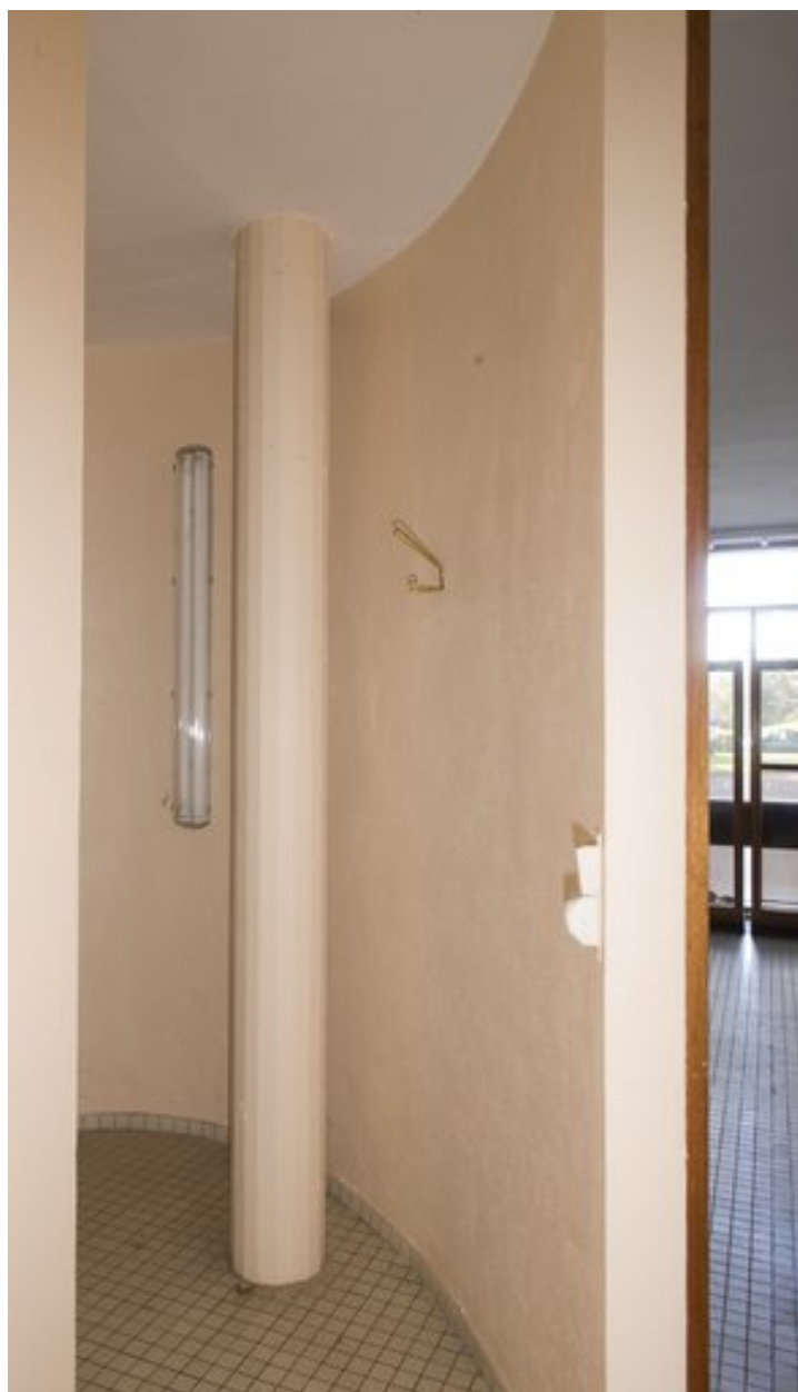
Accès à l'armoire électrique, au rez-de-chaussée.
