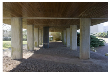
Vue des piliers sous la partie ouest. Phot. Patrice Giraud IVR52_20108500111NUCA
