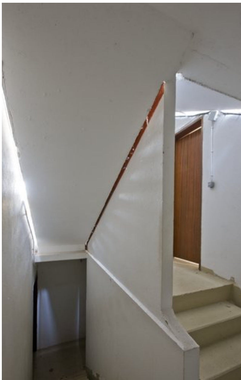
Vue de l'escalier : descente au sous-sol.
