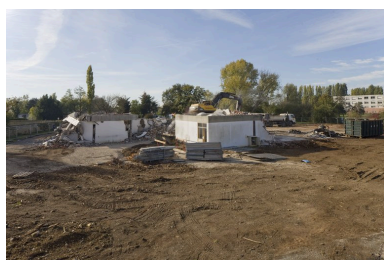
Vue prise du nord-est, en octobre 2010, pendant la destruction du bâtiment. Phot. Patrice Giraud IVR52_20108500443NUCA
