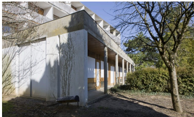
Galerie devant la partie est de la façade sur jardin. Phot. Patrice Giraud IVR52_20108500106NUCA
