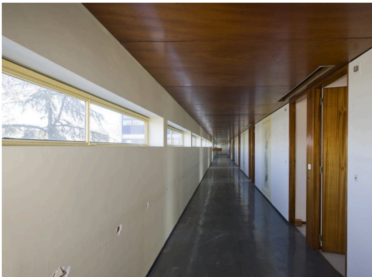
Vue du couloir du premier étage.
