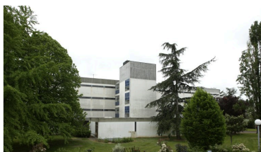
Vue prise du nord-est. Phot. Patrice Giraud IVR52_20078500182NUCA
