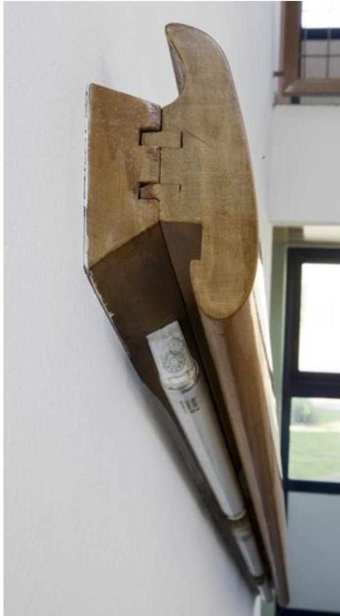
Vue de la rampe d'escalier montrant l'assemblage et le tube de néon placé dessous (le dessin en serait de Marta Pan).
