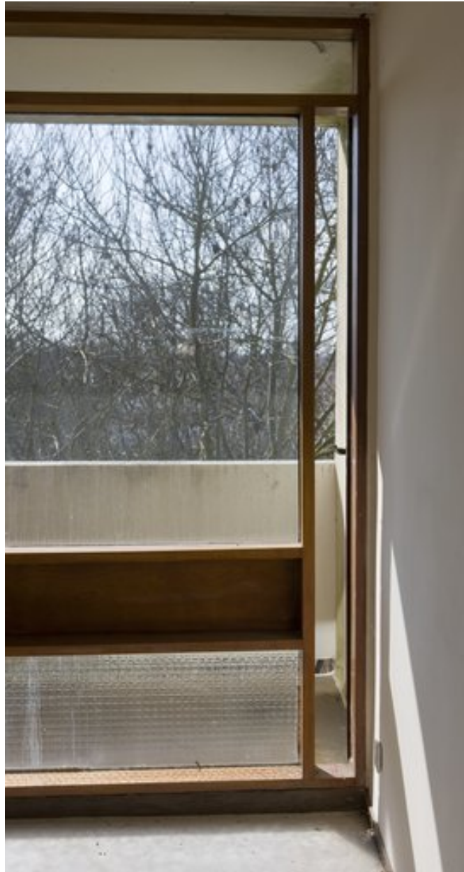
Vue d'une chambre : détail du volet d'aération.
