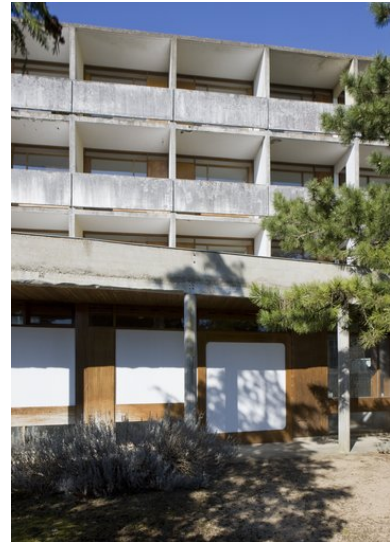
Détail de la partie est de la façade sur jardin. Phot. Patrice Giraud IVR52_20108500108NUCA
