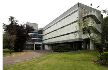
Vue prise du nord-ouest. Phot. Patrice Giraud IVR52_20078500189NUCA
