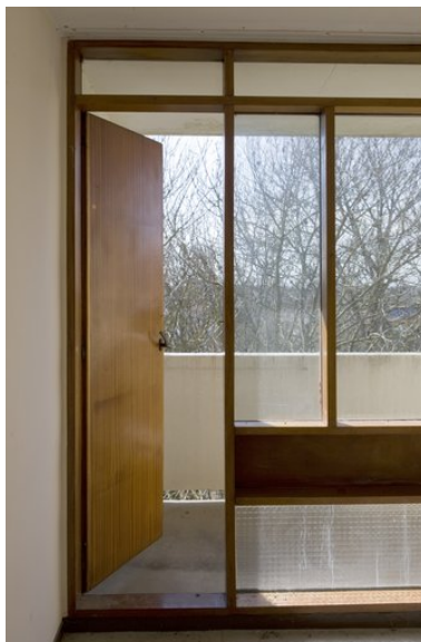
Vue d'une chambre : porte ouverte sur la terrasse. Phot. Patrice Giraud IVR52_20108500083NUCA
