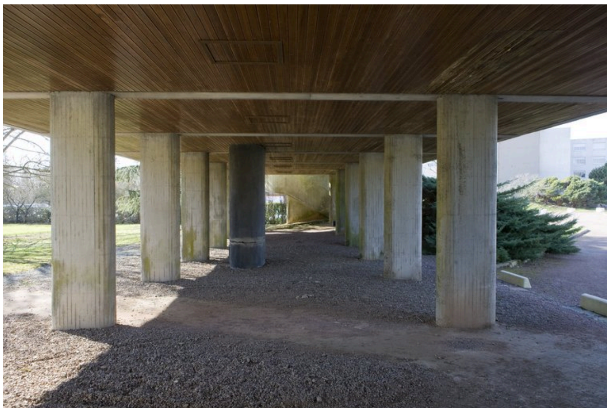
Vue des piliers sous la partie ouest.
