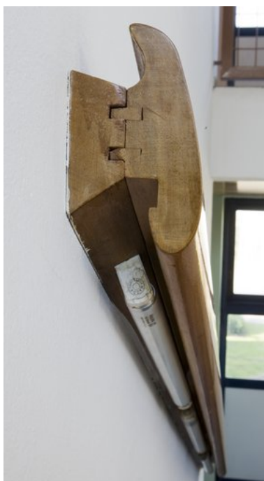
Vue de la rampe d'escalier montrant l'assemblage et le tube de néon placé dessous (le dessin en serait de Marta Pan). Phot. Patrice Giraud IVR52_20108500087NUCA
