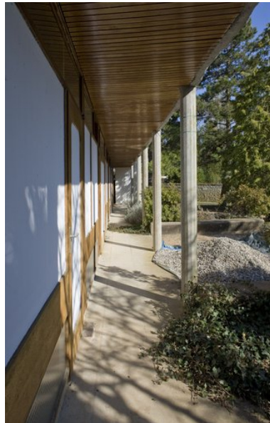
Galerie devant la partie est de la façade sur jardin. Phot. Patrice Giraud IVR52_20108500107NUCA
