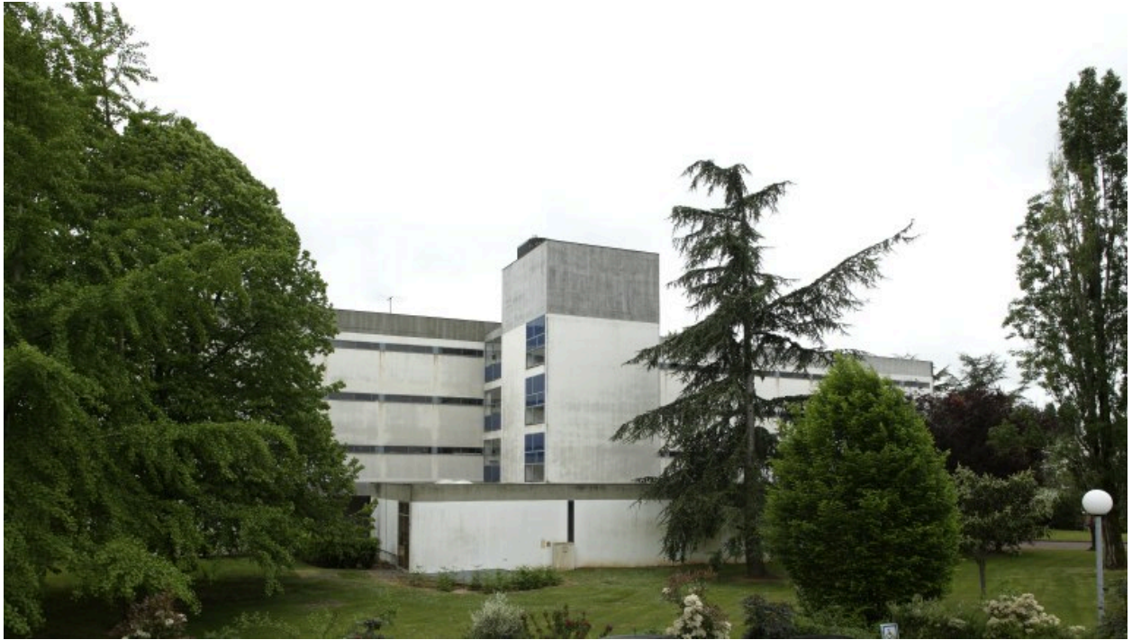
Vue prise du nord-est.
