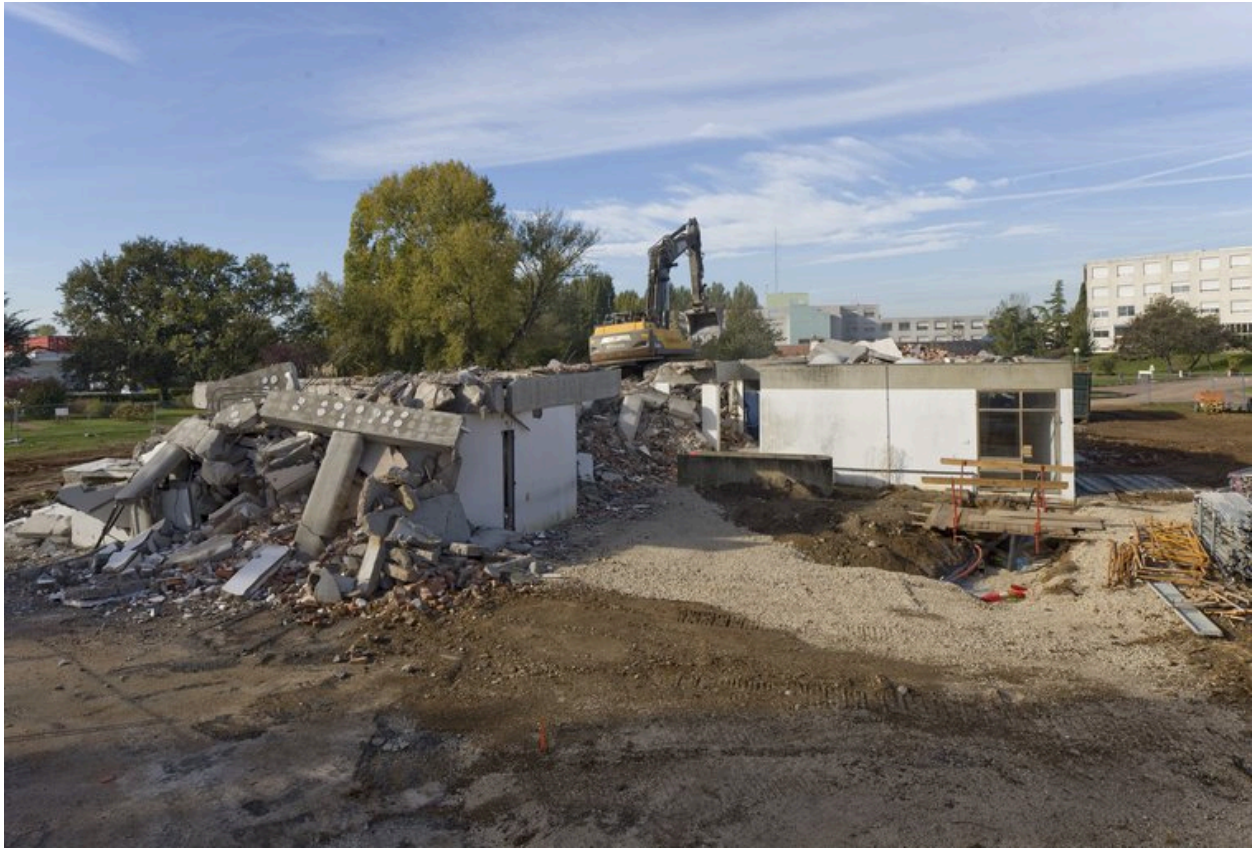
Vue prise du nord-est, en octobre 2010, pendant la destruction du bâtiment.
