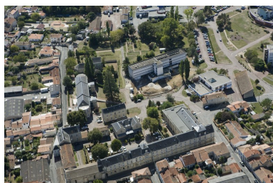
Vue aérienne de l'hôpital montrant la maison de retraite. Phot. Patrice Giraud IVR52_20108500412NUCA
