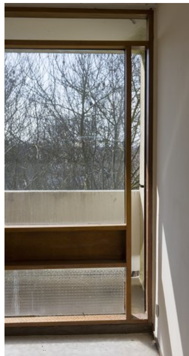
Vue d'une chambre : détail du volet d'aération. Phot. Patrice Giraud IVR52_20108500082NUCA
