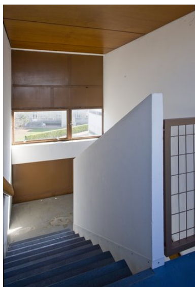
Vue de l'escalier : montée au premier étage. Phot. Patrice Giraud IVR52_20108500086NUCA
