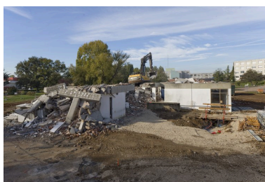
Vue prise du nord-est, en octobre 2010, pendant la destruction du bâtiment. Phot. Patrice Giraud IVR52_20108500444NUCA
