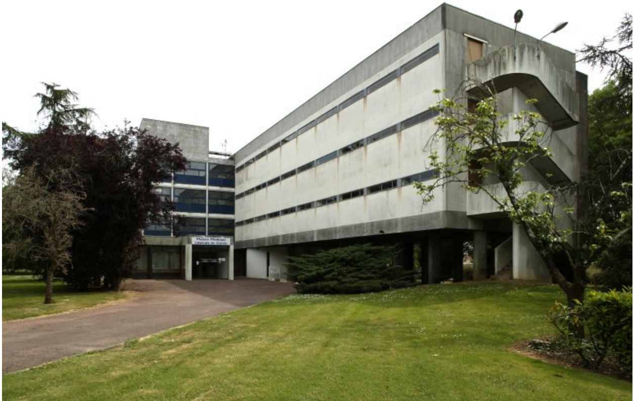
Vue prise du nord-ouest.
