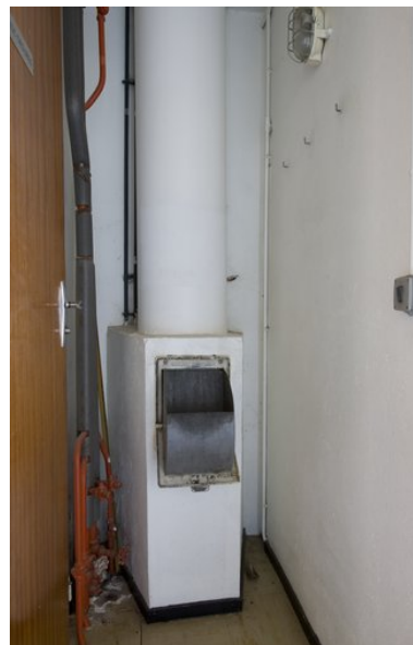
Vide-ordure, au premier étage. Phot. Patrice Giraud IVR52_20108500095NUCA
