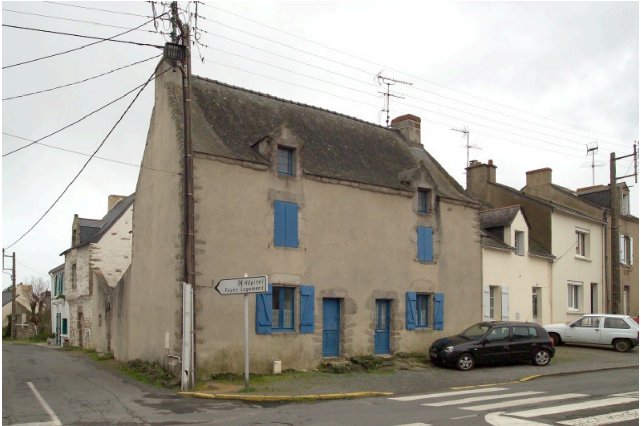
Carrefour rue du Faubourg Saint-Michel et chemin des Moulins ; n°64-66 à l'angle.
