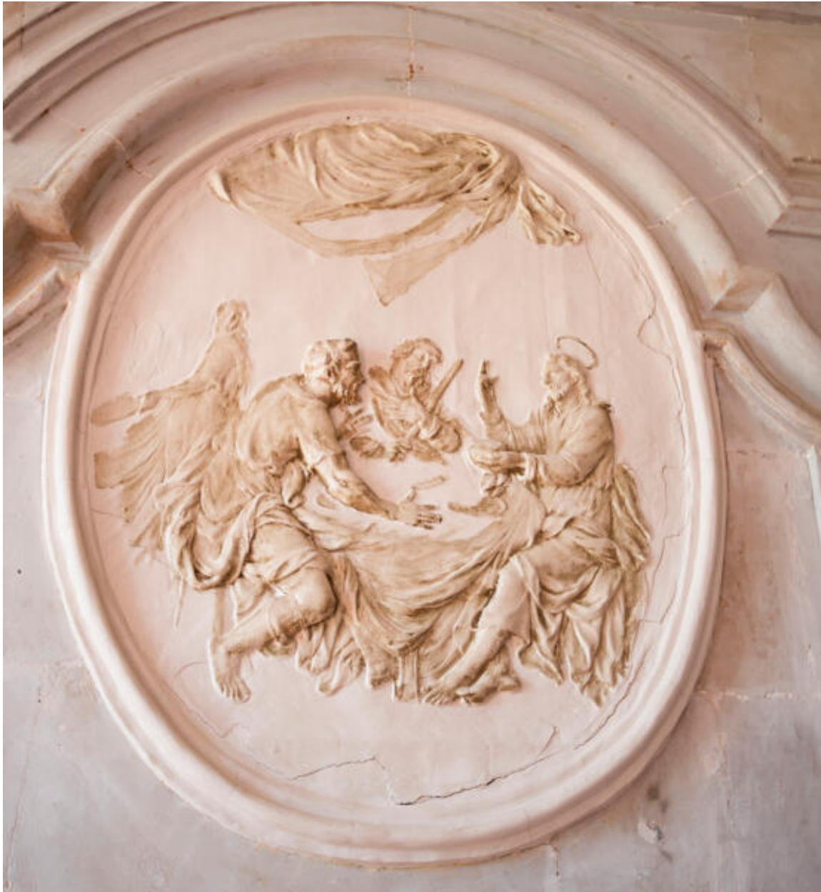
La cheminée de la salle à manger, détail.
