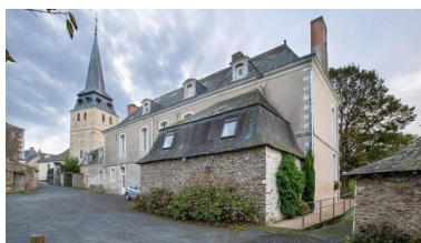
La façade postérieure du presbytère et la dépendance adossée. Repro. Pierre-Bernard Fourny IVR52_20225300970NUCA
