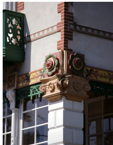
Détail du décor du pilier d'angle à chapiteau composite, des cabochons et frises en terre cuite vernissée et carreaux de ciment. Phot. Denis Pillet IVR52_19954400280XA
