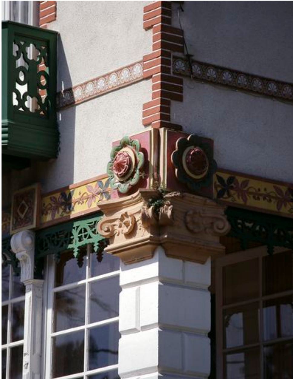
Détail du décor du pilier d'angle à chapiteau composite, des cabochons et frises en terre cuite vernissée et carreaux de ciment.
