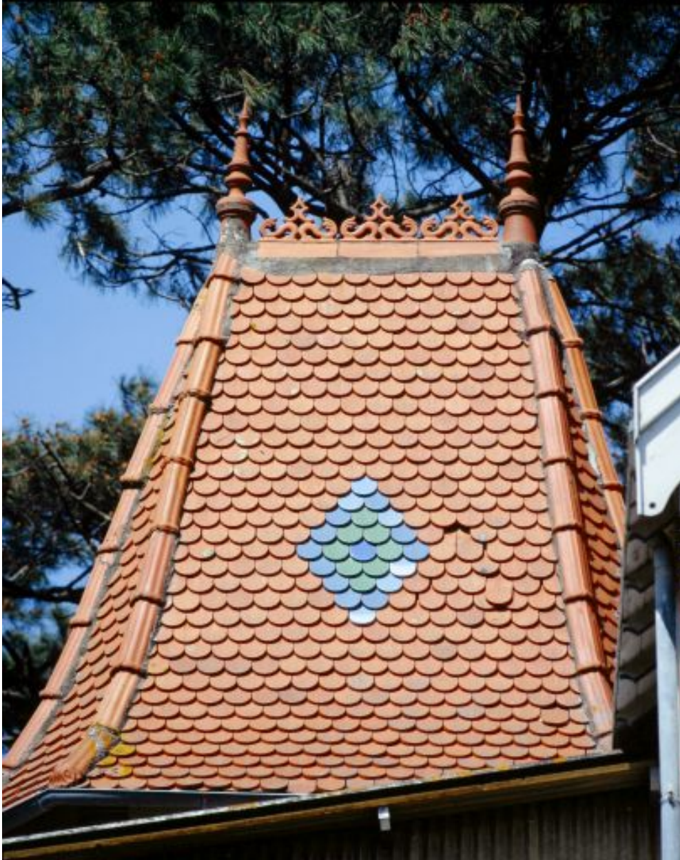
Détail du toit polygonal, couvert de tuiles en écailles, de la tour d'angle.
