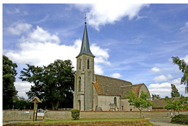
Vue générale depuis le sud-ouest. Phot. François Lasa IVR52_20077200799NUCA
