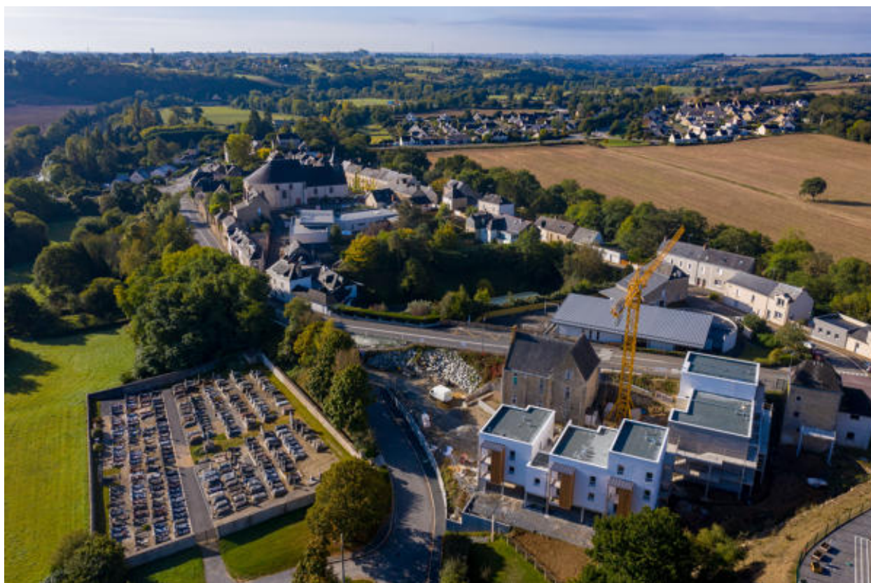
Une vue aérienne du bourg, depuis le nord.
