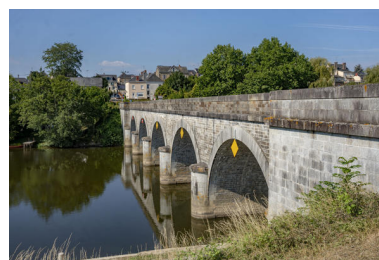
Le pont du bourg. Phot. Pierre-Bernard Fourny IVR52_20215301244NUCA
