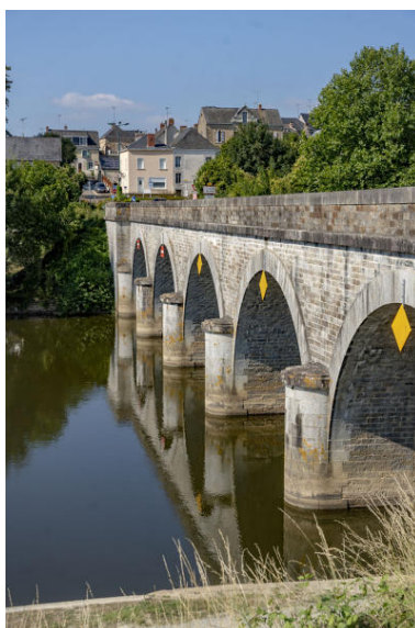
Le pont du bourg. Phot. Pierre-Bernard Fourny IVR52_20215301243NUCA
